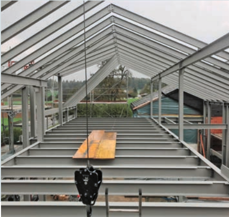
Das Stahltragwerk noch ohne Ausfachungen. Die Zwischendecke wird im Wohnbereich zur Brücke.
