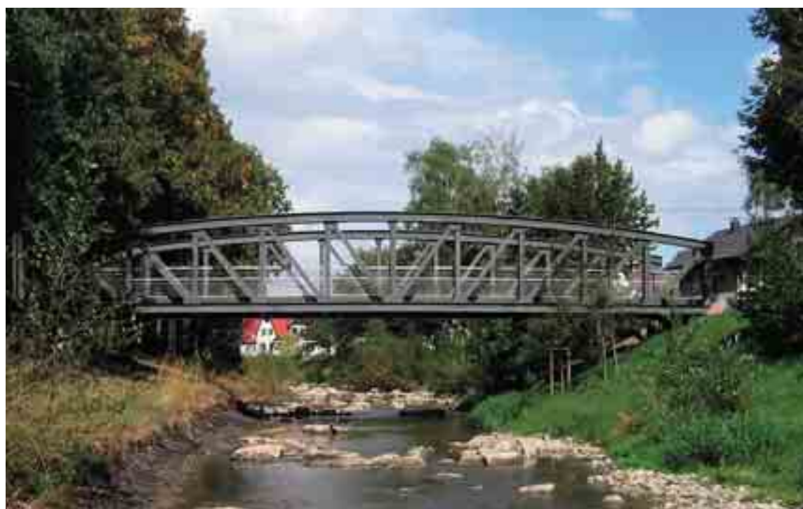
L'ancien pont routier construit voici plus de nonante ans par rivetage à chaud est aujourd'hui utilisé à un autre emplacement comme pont piéton.
