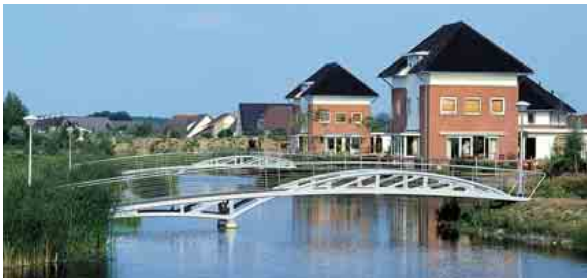
Deux ponts avec structure porteuse asymétrique relient parc et zone résidentielle.
