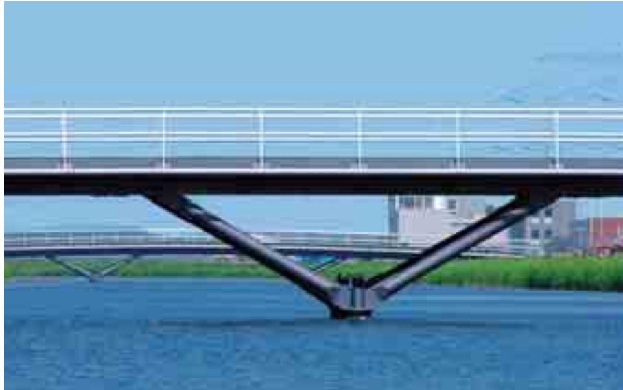
Tous les ponts sont basés sur un système modulaire composé de piles couplées en V.
