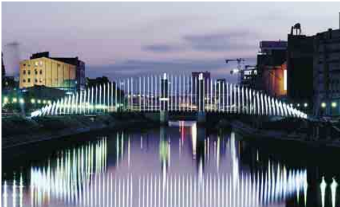
La nuit, le pont est éclairé par des éléments à LED intégrés.
