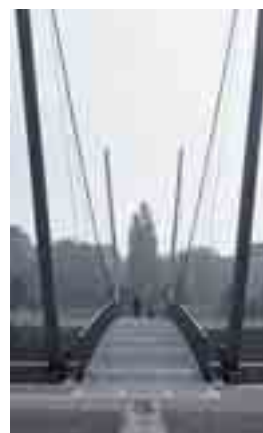
Lorsque l'on fait basculer le haut des mâts vers l'extérieur, le pont se soulève en son milieu de 10,60 m - en position normale, la hauteur de la «bosse» est de 1,10 m.
