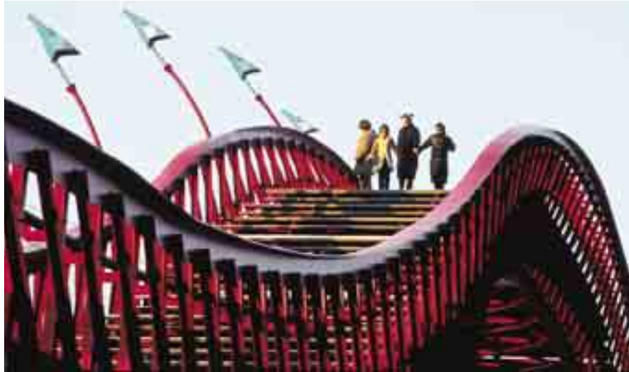
Les poutres en treillis constituent en même temps le parapet sur les côtés du tablier en escalier.
