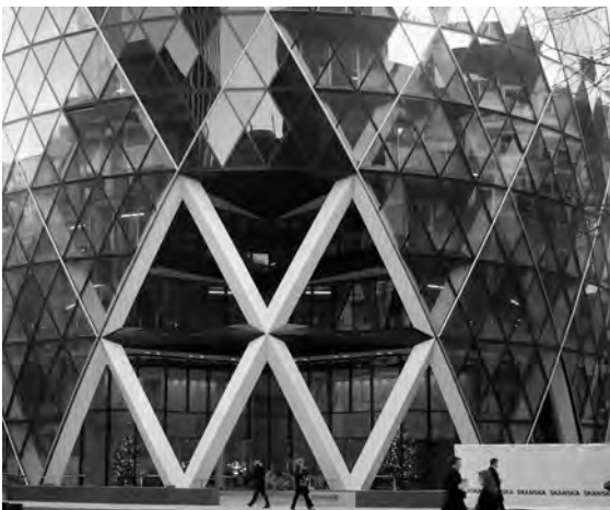
Direction générale de la Swiss Re à Londres (Royaume-Uni), 2004, Foster & Partners.
