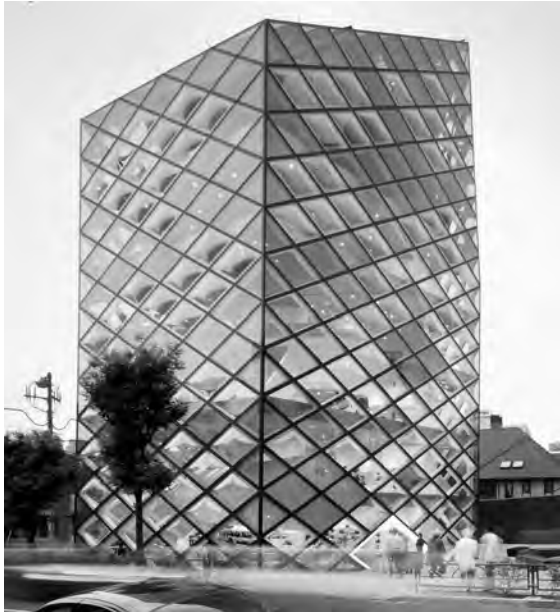
Epicentre de Prada Aoyama à Tokyo (Japon), 2003, Herzog & de Meuron. Les losanges constituent des bandes inclinées; du côté de l'entrée, le bord du toit suit l'inclinaison des bandes. Le coude au coin droit du bâtiment ne se remarque guère.
