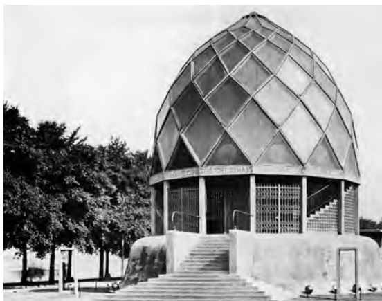
Maison de verre à l'exposition du Werkbund à Cologne (Allemagne), 1914, Bruno Taut. Spirales à gauche ou à droite ? La coupole a été conçue en fer mais réalisée en béton armé.
