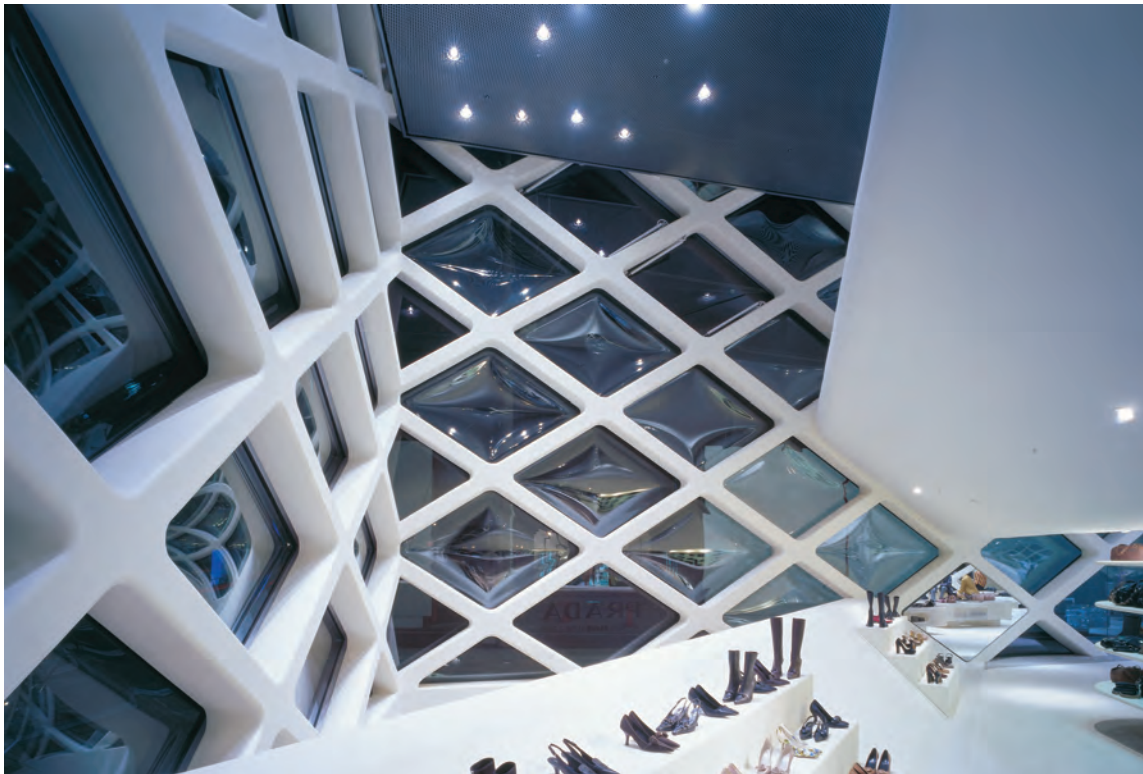
Les dalles qui ne s'étendent pas jusqu'aux façades génèrent des espaces de grande hauteur. Au rez-de-chaussée, une balustrade inclinée délimite l'espace.
