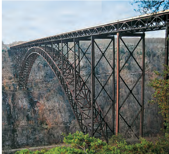
New-River-Gorge Brücke in West Virginia, USA, Spannweite 518 m, erbaut 1977.
