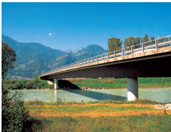
links: Strassenbrücke über die Rhone bis Illarsaz (Verbindungsstrasse Vionnaz-Aigle VD) rechts: Strassenbrücke über die Saane (Enney-Estavannens FR)
