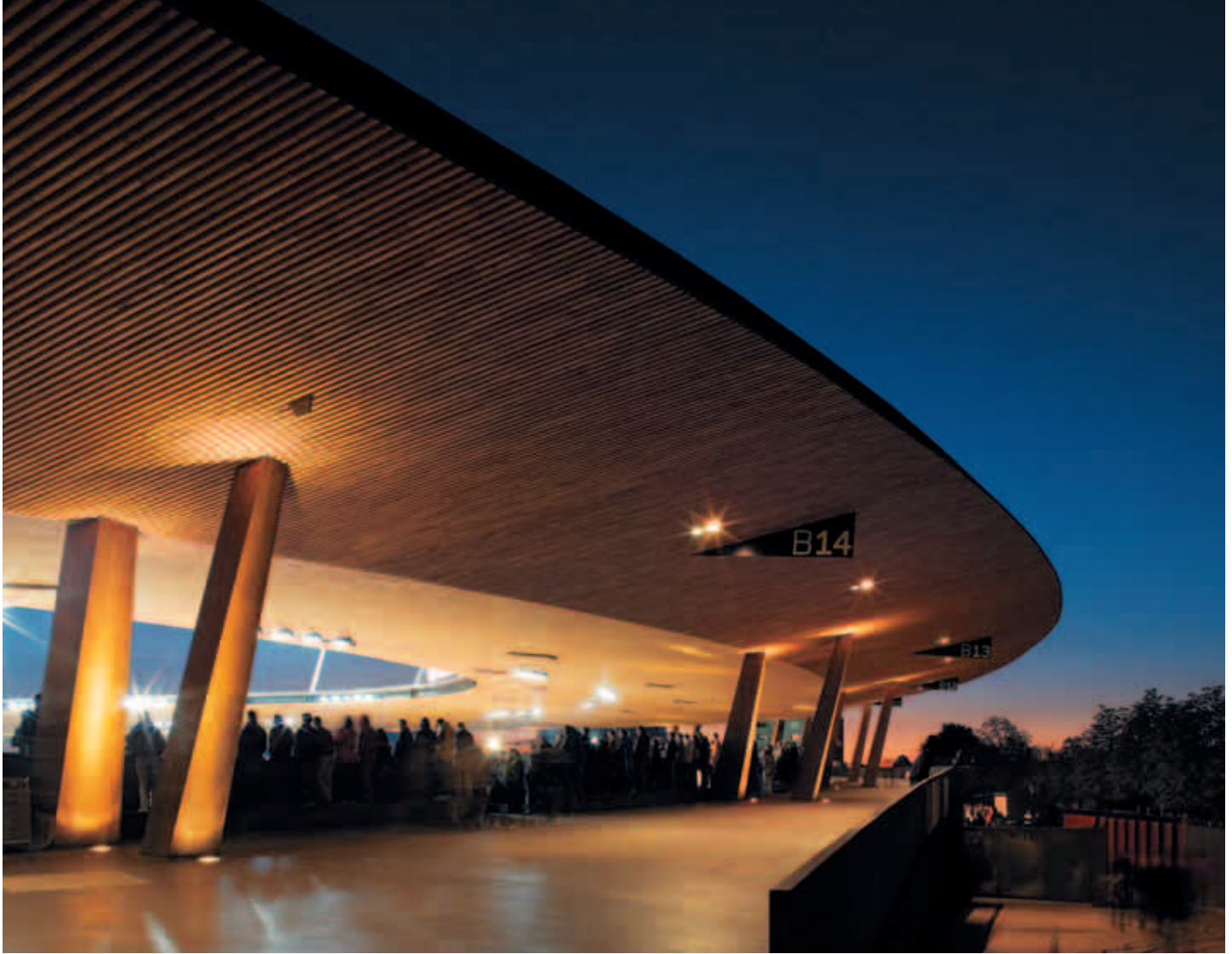
Une généreuse rampe d'accès, très légèrement inclinée, couronne les tribunes et permet de découvrir aussi bien l'espace ouvert du stade que la ville de Zurich.
