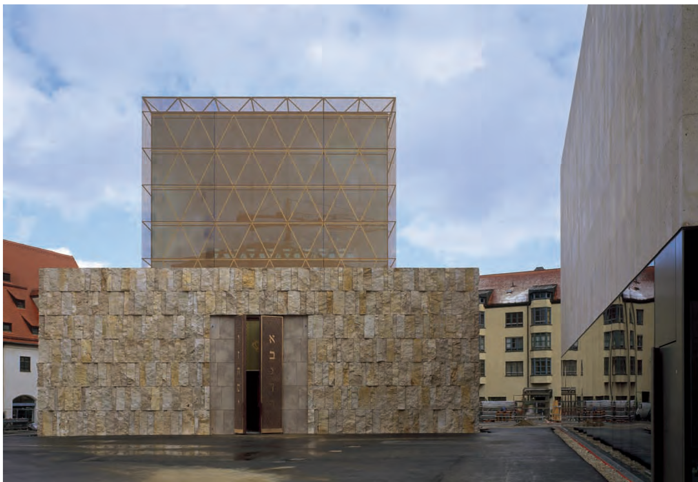
Un socle en travertin constitue un soubassement solide pour la lanterne de la synagogue. Il évoque le mur des Lamentations à Jérusalem.
