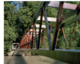
Passerelle sur la Limmat à Baden Baden 2007 pont en caisson à treillis et tour avec ascenseur 52 m/3 m 52 t, S235 + S355 Stadt Baden, Gem. Ennetbaden Henauer Gugler AG, Zurich Zwahlen & Mayr SA, Aigle
