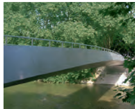
Passerelle Herter Zurich 2005 pont poutre à caisson soudé 43 m/5 m 66 t Ville de Zurich ACS Partner AG, Zurich Josef Meyer, Emmen
