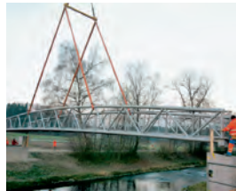
Passerelle pour cyclistes à la Birchstrasse Glattbrugg-Opfikon 2007 pont à treillis en tubes avec tablier à dalle orthotrope en acier 30 m/4 m 24 t, S355 Canton de Zurich dsp Ingenieure und Planer AG Zwahlen & Mayr SA, Aigle
