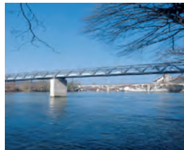
Pont Isenlauf Bremgarten AG 2003 pont à treillis, 5 parties montées depuis des pontons 24 + 40 + 28 = 92 m/3 m 26 t, S235 + S355 Stadt Bremgarten Henauer Gugler AG, Zurich Jakem AG, Münchwilen
