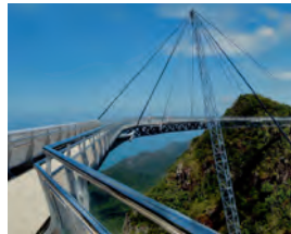
Passerelle panoramique Langkawi Langkawi, Malaisie 2004 pont à treillis haubané avec pylônes à treillis 125 m/2-4 m 53 t Langkawi Development Authority Höltzchi & Schurter, Zurich BBR + Khean Seng Engineering
