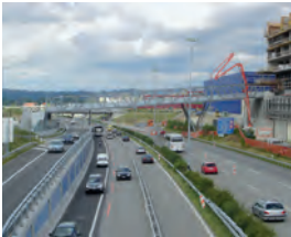
Deux ponts sur la A1 AFG Arena St. Gallen 2008 ponts poutres à treillis, trois travées sur piles en V 76 m et 65 m/12 m 310 t, S355 HRS AG, Saint-Gall Borgogngo Eggenberger Aeppli & Co Stahlbau, Gossau
