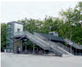
Pont Herter Zurich 2005 pont poutre en auge, en tôles soudées 16 m/5 m 40 t Ville de Zurich ACS Partner AG, Zürich Josef Meyer, Emmen
