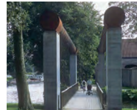
Pont sur le Coupurekanal Bruges, Belgique 2002 pont levant à tablier suspendu à des poutres en tube d'acier enrouleur 37 m/3 m 35 t Vlaamse Gemeenschap Conzett Bronzini Gartmann Metaalconstructie Aelterman
