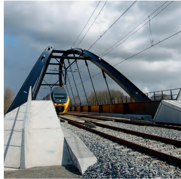
La caténaire est intégrée dans la structure du pont.
