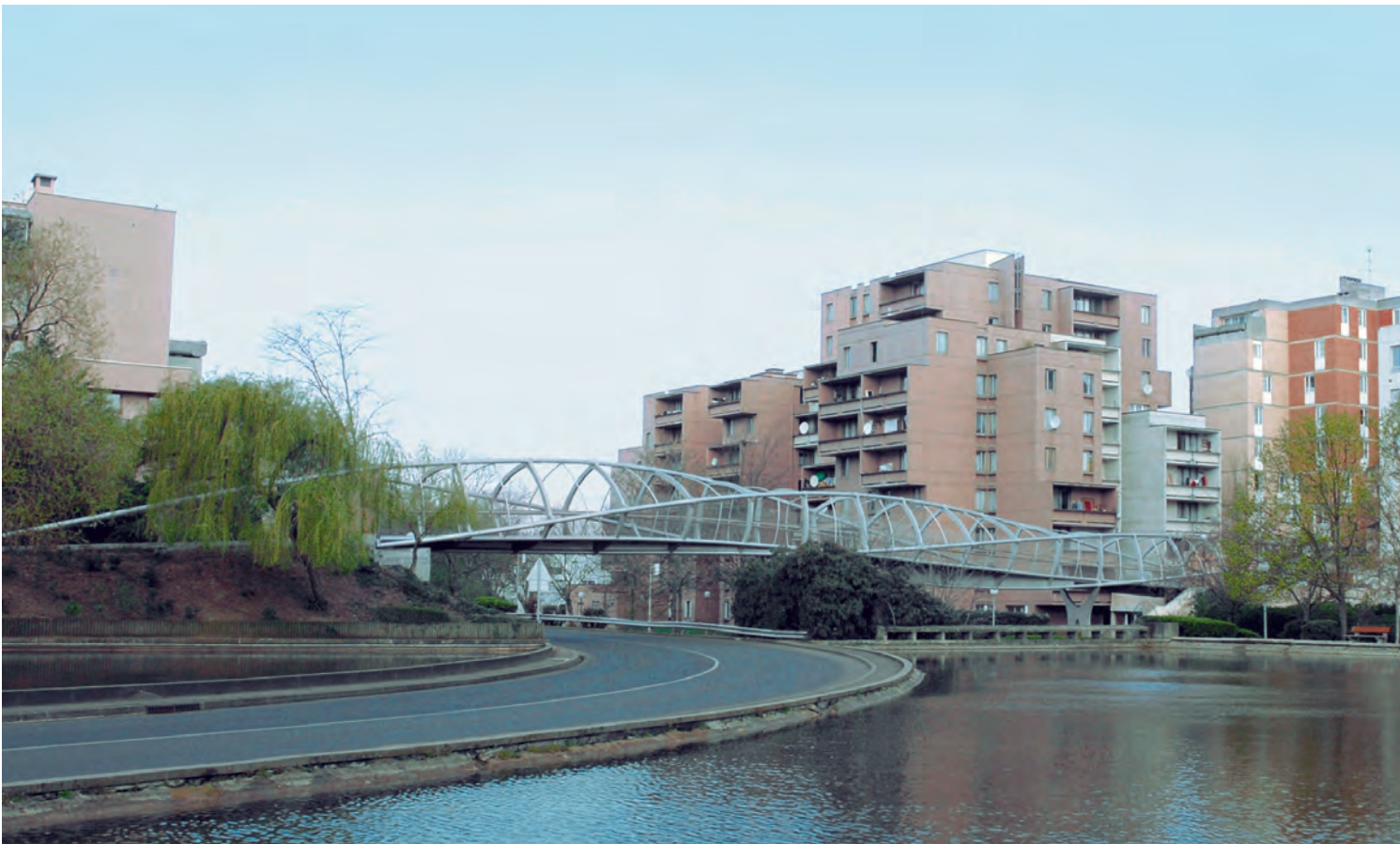
La passerelle, longue de 62 mètres et large de 3, et pesant 55 tonnes, passe en vrille au-dessus des deux rues.
