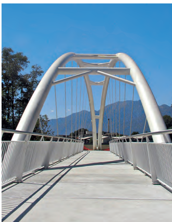
Les deux arcs parallèles, légèrement inclinés l'un vers l'autre, s'écartent au milieu de la passerelle et convergent à nouveau à ses extrémités.
