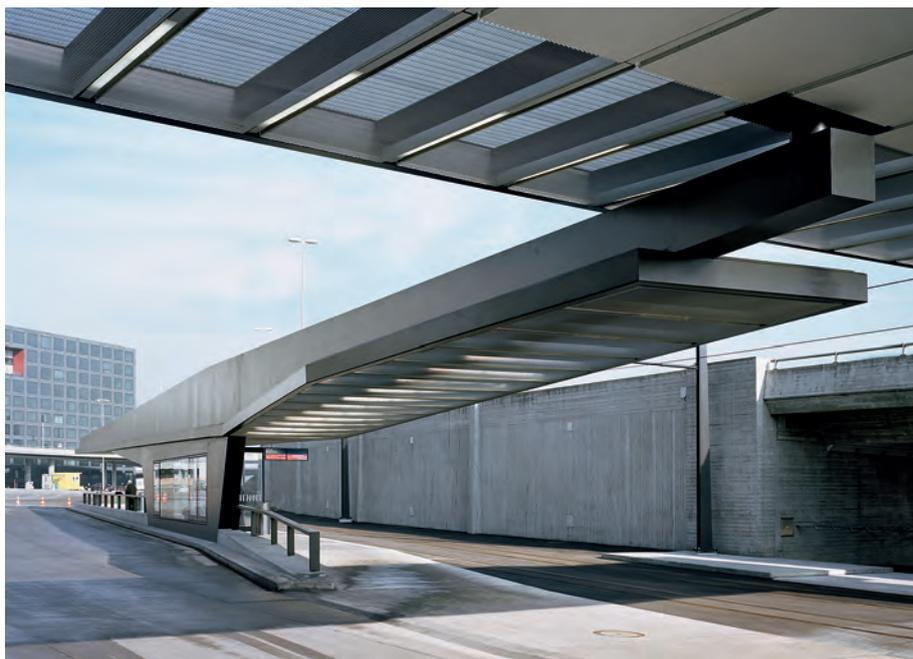
Les imposantes poutres-caissons en acier permettent de conférer aux toits en porte-à-faux une impression de légèreté.
