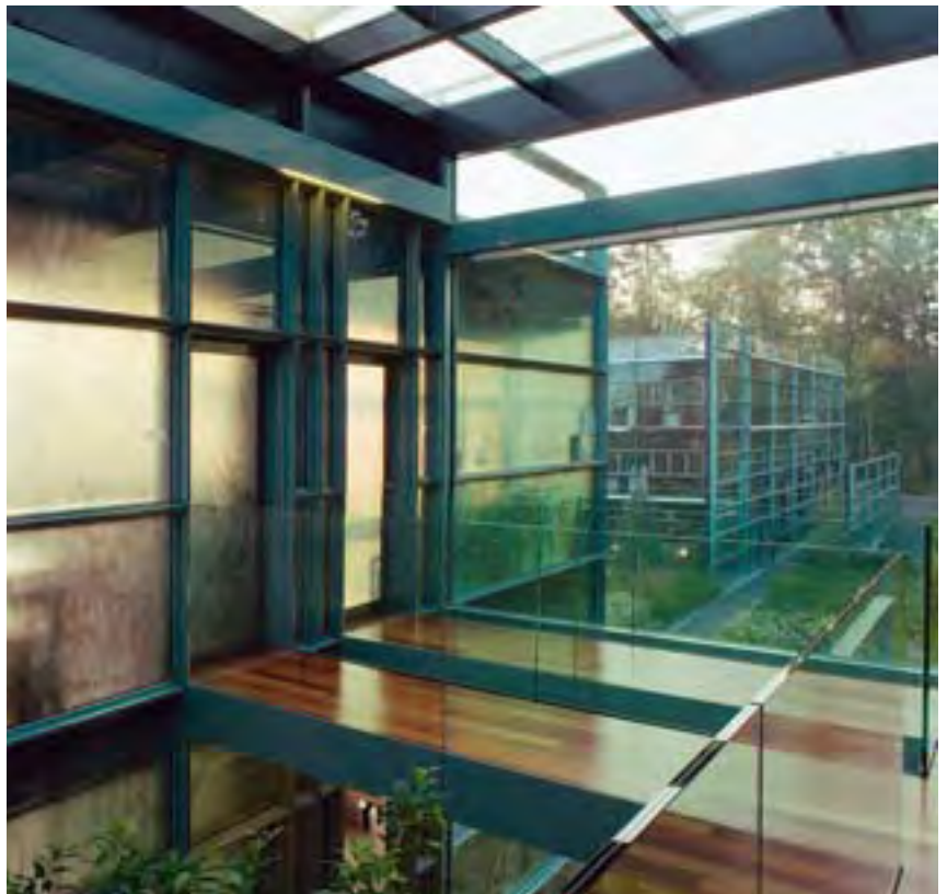
Vertikale und horizontale Profile wurden möglichst gleich dimensioniert, um der Struktur Ebenmass zu verleihen.
