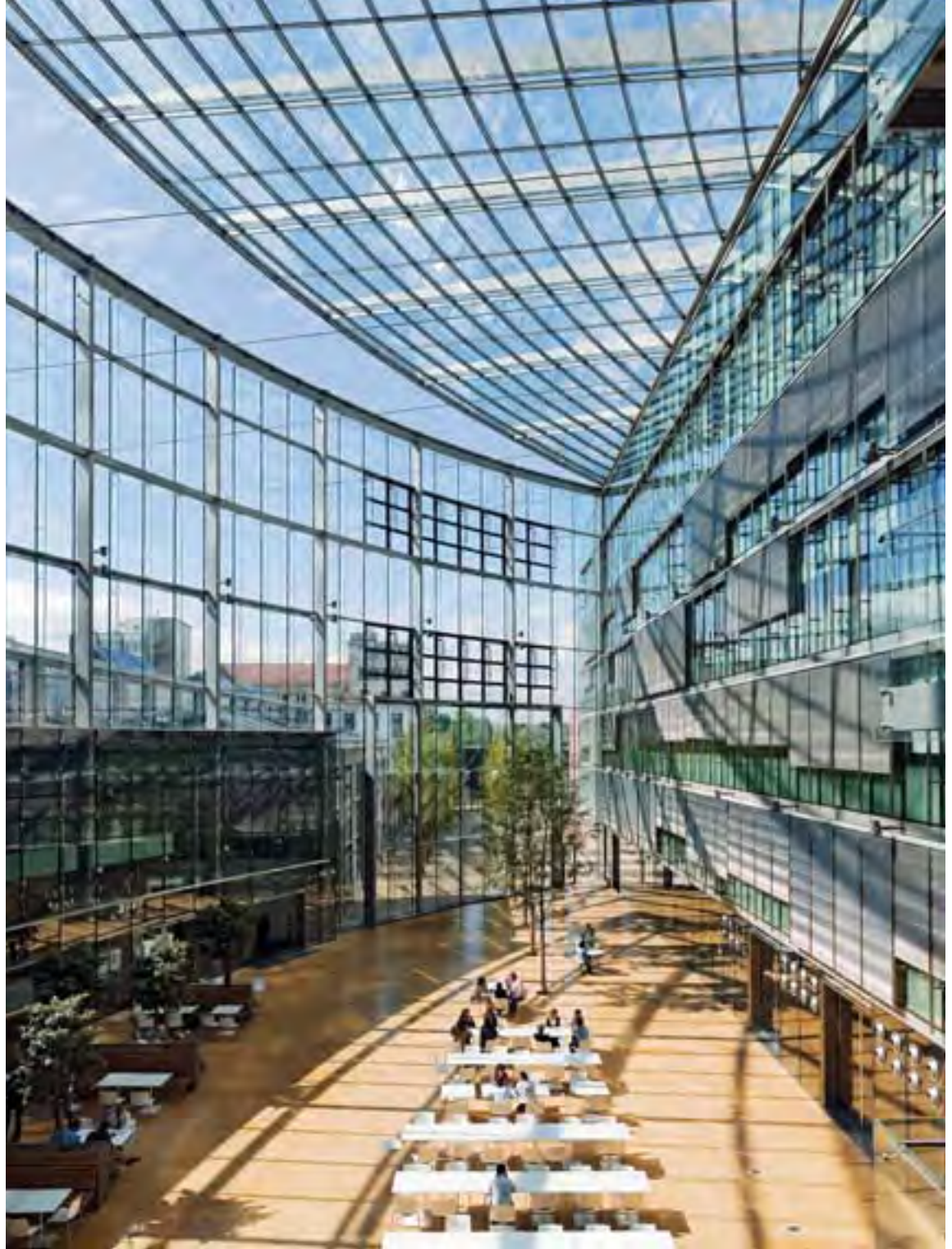
Das weltweit grösste zu öffnende Glasdach bringt Frischluft in das Forum, das als Begegnungsort für den gesamten Campus dient.
