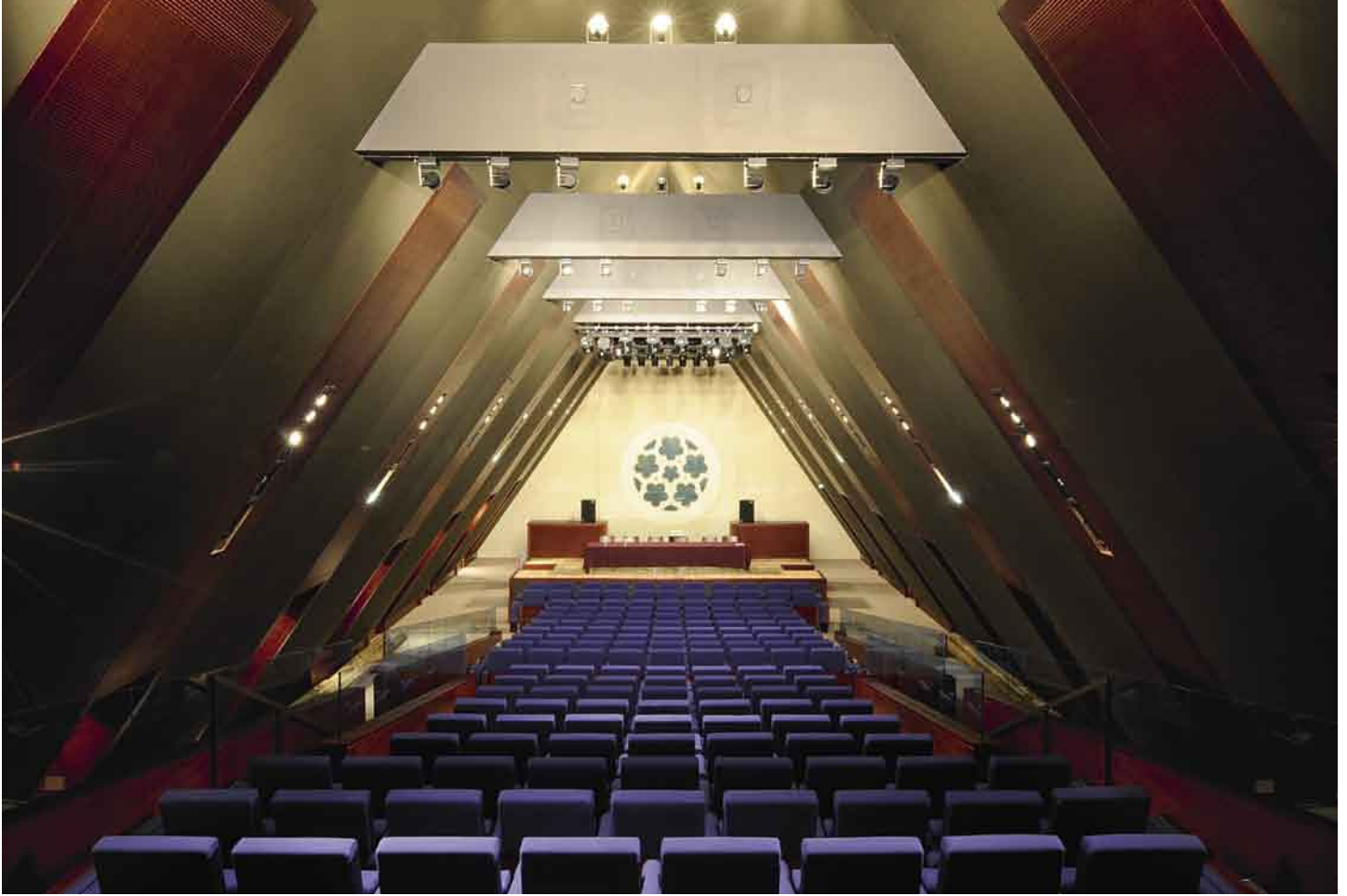
Reconstruit avec une nouvelle charpente métallique, le comble abrite désormais un auditoire moderne.
