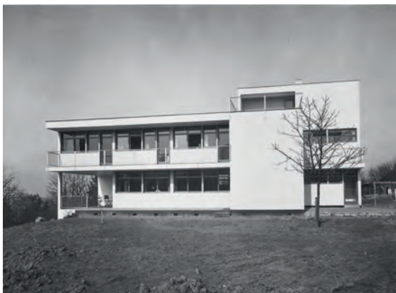
3+4 Maison Colnaghi, Riehen, 1927, archi- tectes: Hans Schmidt et Mart Stam
