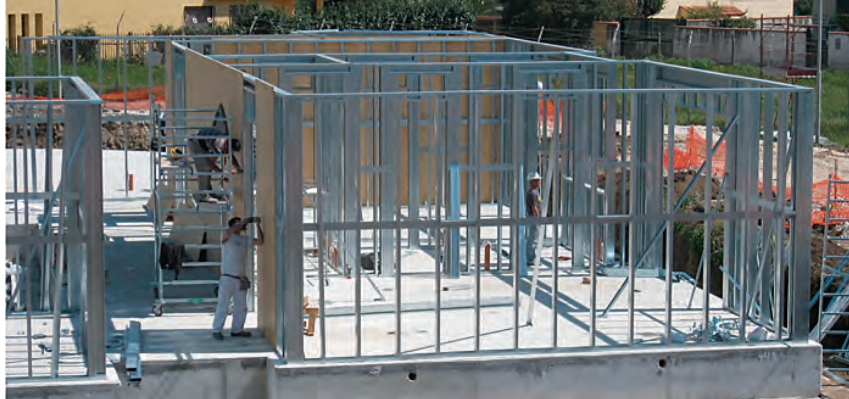
Fig. 25: Construction de type traditionnel en profils d'acier formés à froid combinée avec du bois pour une école des British Forces à Naples.
