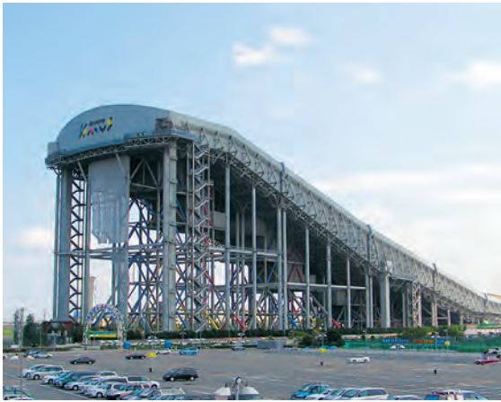
9 Dans la halle de ski d'intérieur SSAWS (Spring-Summer-Autumn-Winter Ski), à Tokyo, la construction a été subdivisée en cinq tronçons reliés par des assemblages articulés, de manière à réduire les contraintes générées en cas de séisme.
