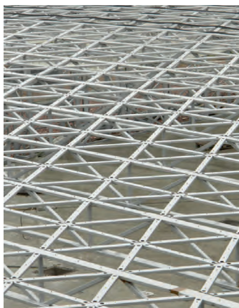
Structure porteuse en acier
