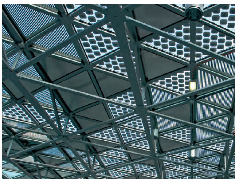
Vue intérieure de la toiture
