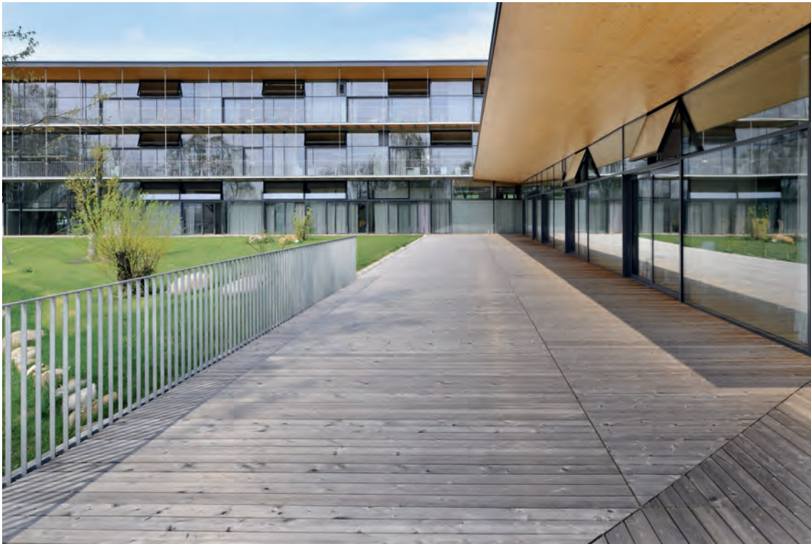
Vue sur les salles de classe du collège orientées au sud avec prolongement extérieur de l'école primaire au premier plan.
