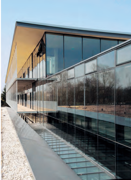
Vue sur le bandeau vitré qui éclaire zénithalement le vestiaire de l'école primaire. A l'arrière-plan, les salles de classe du collège.
