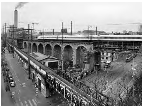
Le viaduc avant sa réaffectation.
