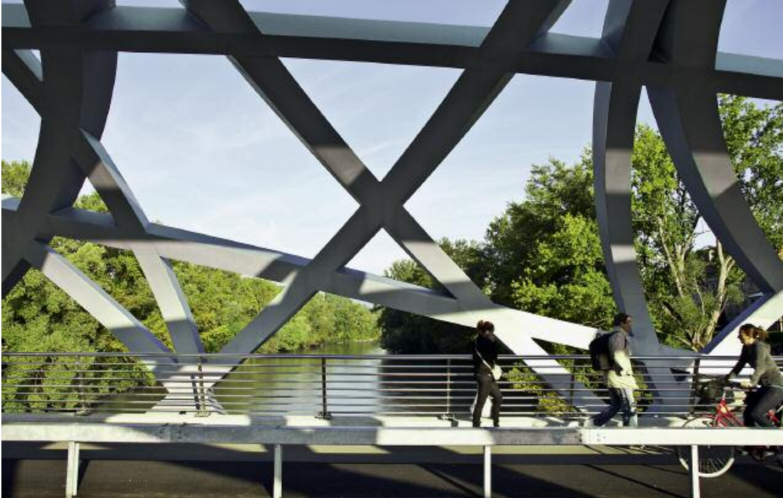
La structure ajourée offre des vues variées sur la ville et les berges de l'Arve.
