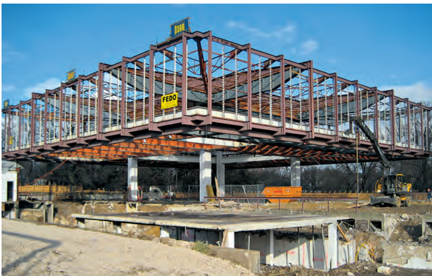
L'ossature métallique a été rénovée et renforcée sur place.
