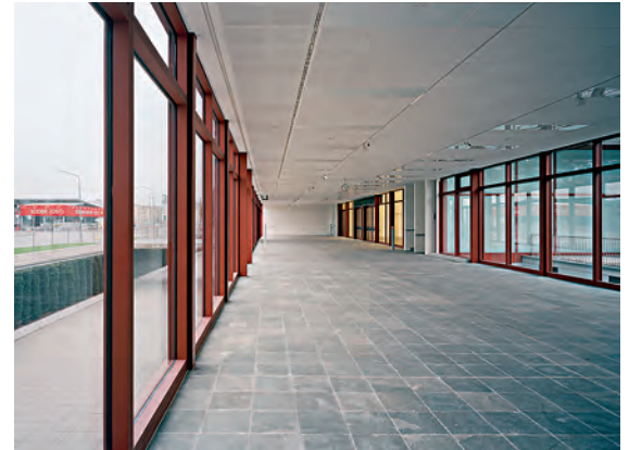
Le foyer après rénovation
