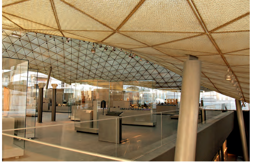
La verrière ne repose que sur quelques poteaux légèrement inclinés.
