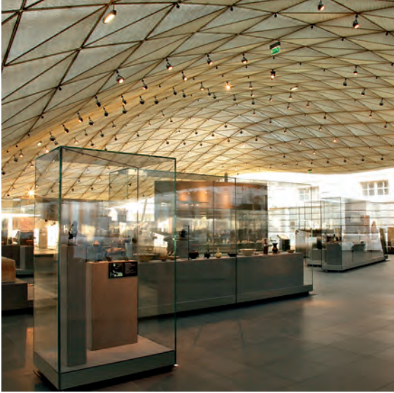
Les mailles de métal déployé confèrent à la toiture un aspect quasi textile.
