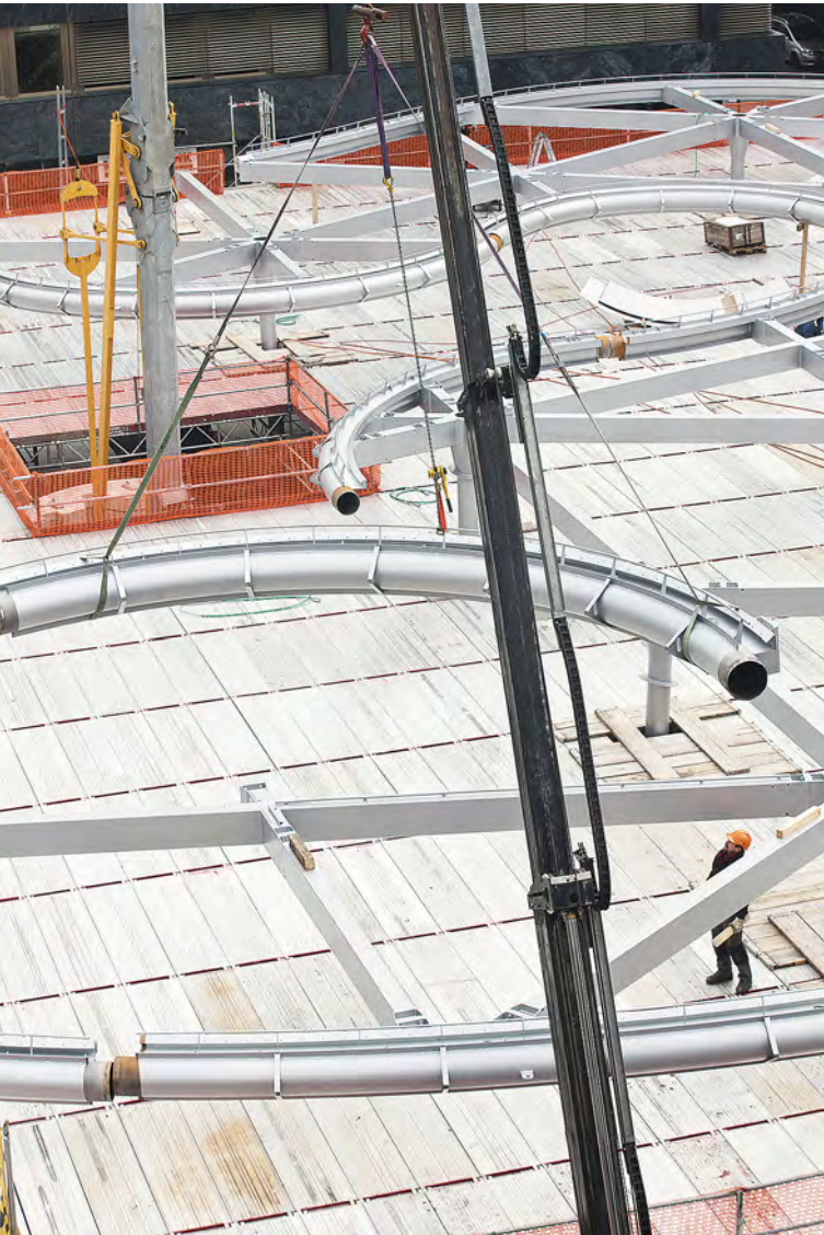
Manutention et ajustement des tubes cylindriques des poutres de rive.
