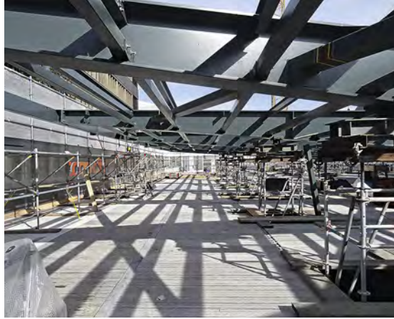
Montage des poutres- consoles, de la poutre de rive et de l'ossature secondaire de l'auvent.
