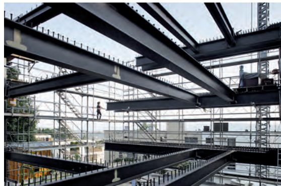
Montage de l'ossature métallique
