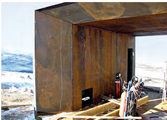
Au cours du chantier déjà, l'ouvrage en acier brut avait changé de couleur. Côté nord, le pavillon est fermé par sept panneaux vitrés de deux mètres par trois environ.
