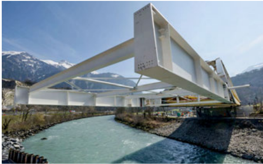
Lancement du pont au-dessus du Rhône.
