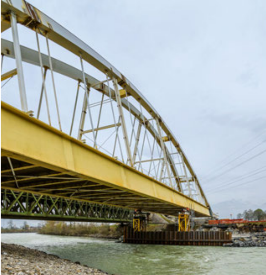
En haut et à gauche : la structure métallique a franchi le pont. En haut et à droite : détail d'une poutre longitudinale. En bas à droite : partie métallique de l'auge mixte acier/béton.
