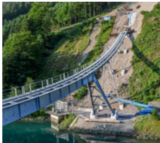
Progrès du pont à la station aval (de gauche à droite).
