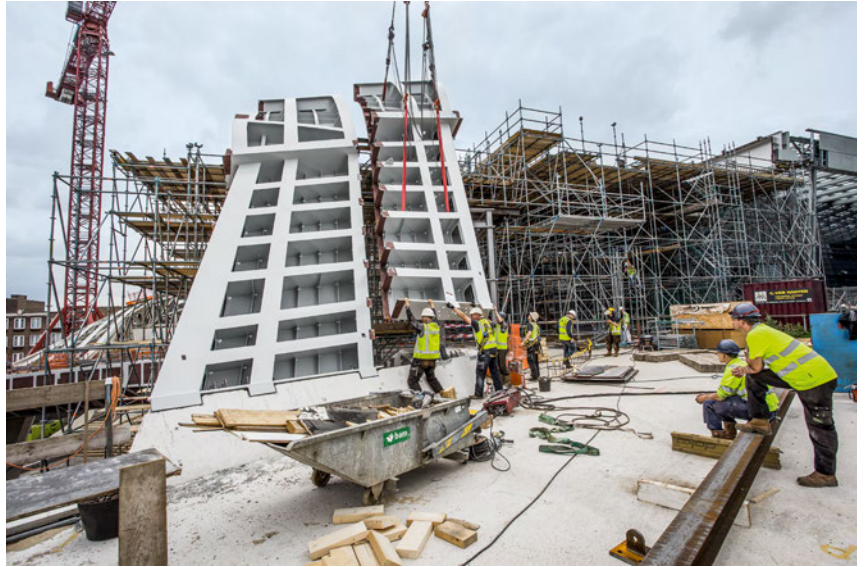
Livraison et montage des éléments métalliques préfabriqués.
