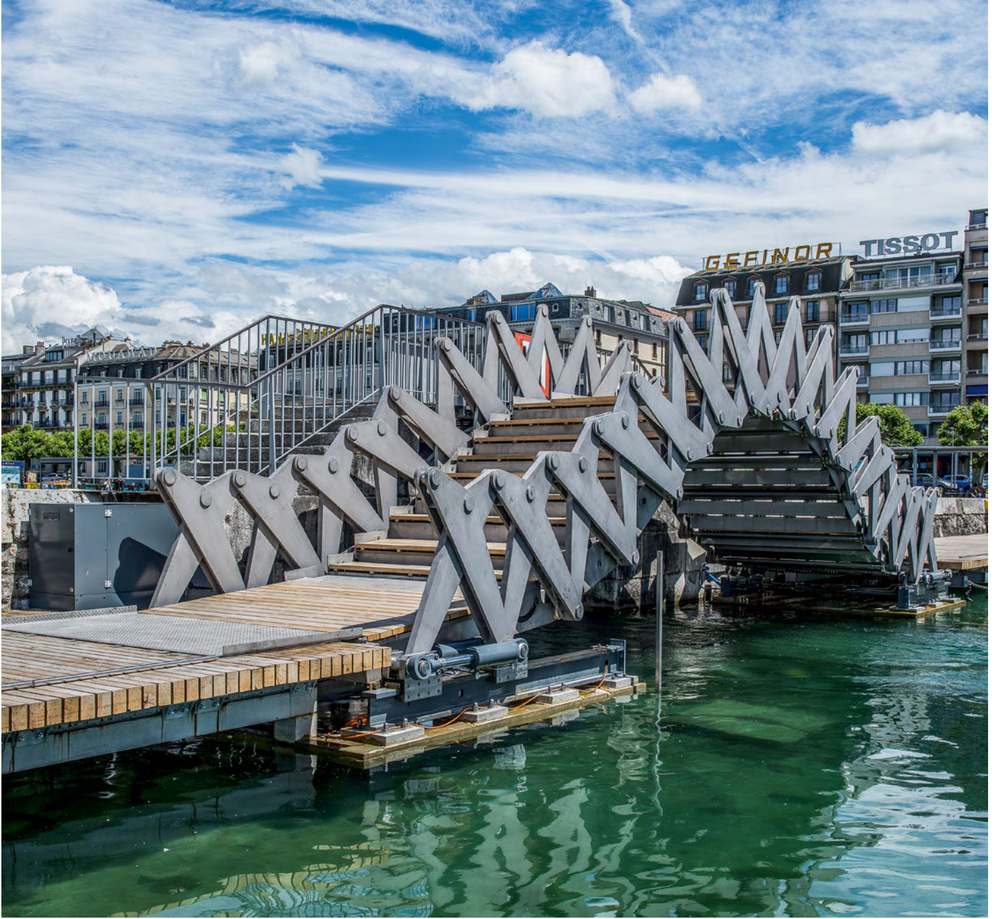
En avant-plan, la passerelle mobile en position haute ; en arrière-plan, la passerelle historique de la jetée des Eaux-Vives.
