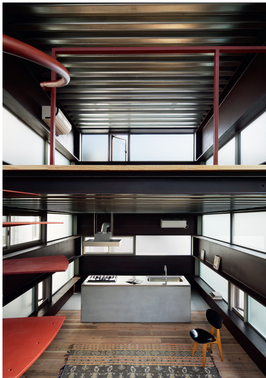
Vue depuis l'escalier dans la cuisine et la mezzanine : les poutrelles laquées noir de l'ossature donnent tout son caractère à l'espace intérieur.
