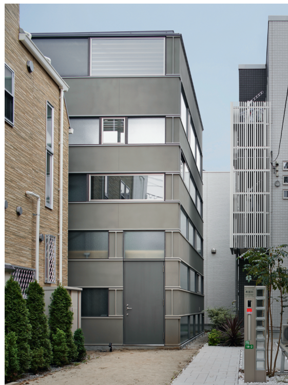
Vue extérieure : vue axonométrique de l'empilement des poutrelles ; entre celles-ci, on a utilisé des vitrages différents selon l'emplacement.
