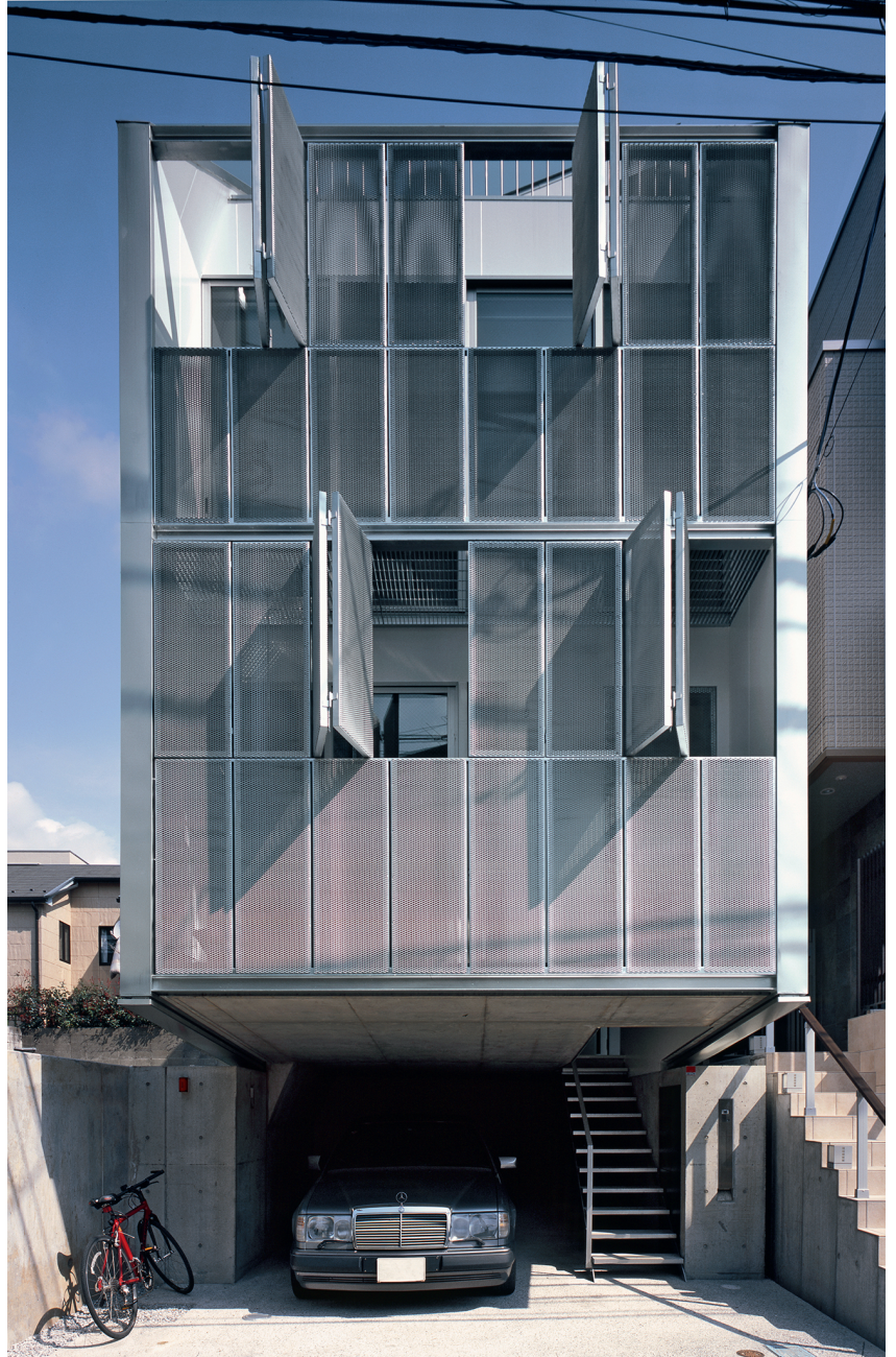
Vue depuis la rue : des volets métalliques perforés assurent la protection solaire de la façade sud.
