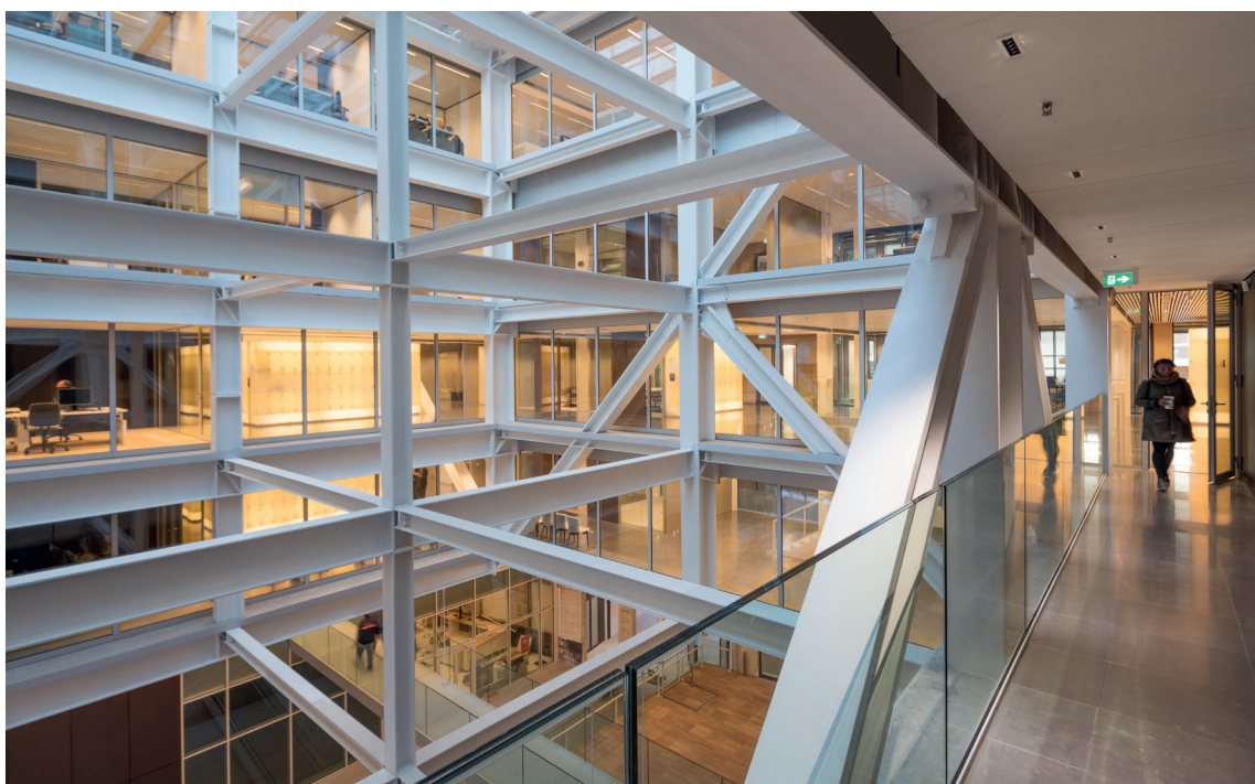
Milieu : la structure en acier, de conception modulaire, crée une flexibilité dans la configuration et l'utilisation des volumes.
