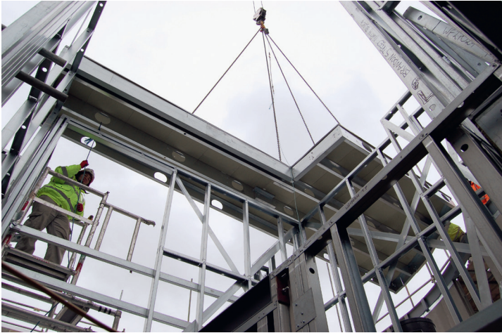
Les différents éléments ont été préfabriqués en atelier, puis assemblés sur le chantier.
