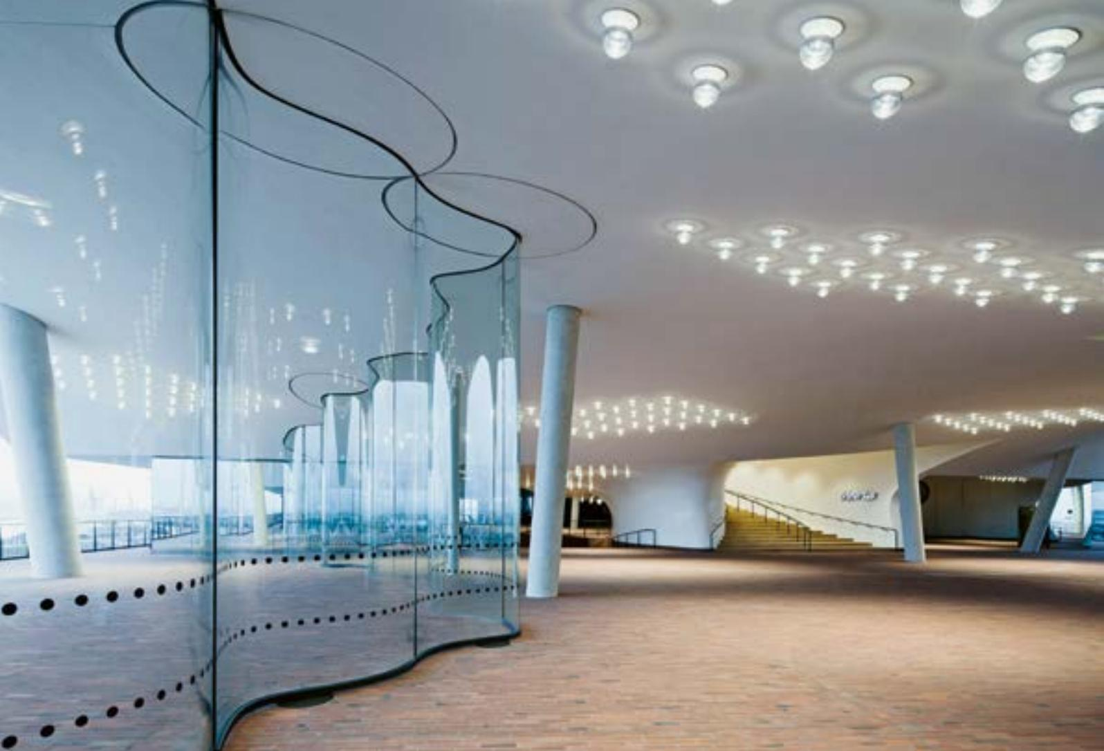
Haut : le vitrage ondulant entre Plaza et terrasse délimite l'espace intérieur avec une saisissante élégance, conjugaison de l'esthétique et de la statique : les courbures donnent au vitrage la stabilité nécessaire pour résister au vent (valeur de calcul type des pressions dues au vent :
