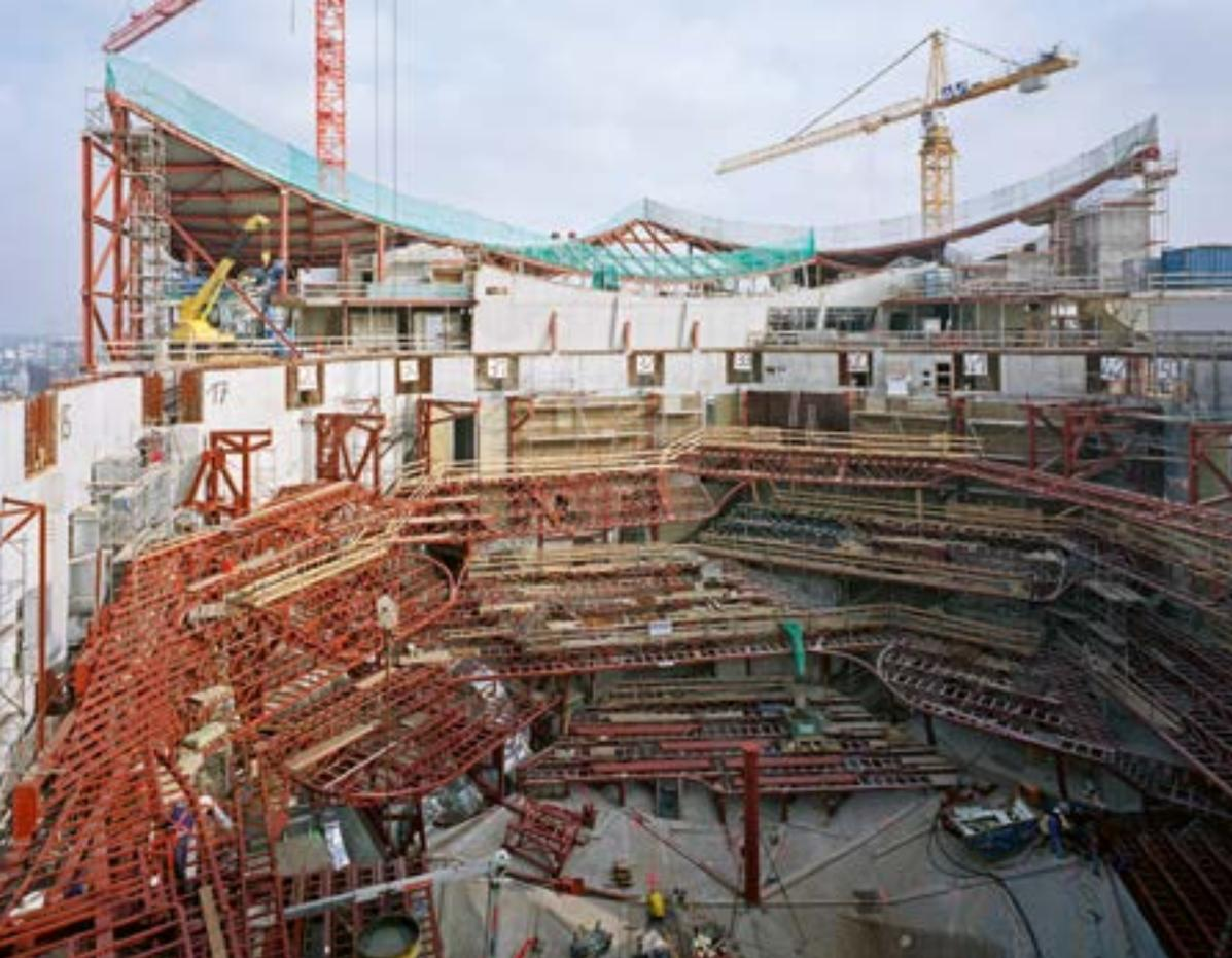
Coque extérieure de la grande salle de concert, creuset géant en béton, pendant les travaux, en 2009. La structure métallique de la boîte intérieure et des balcons, étagés comme les terrasses d'un vignoble, est en cours d'installation.
