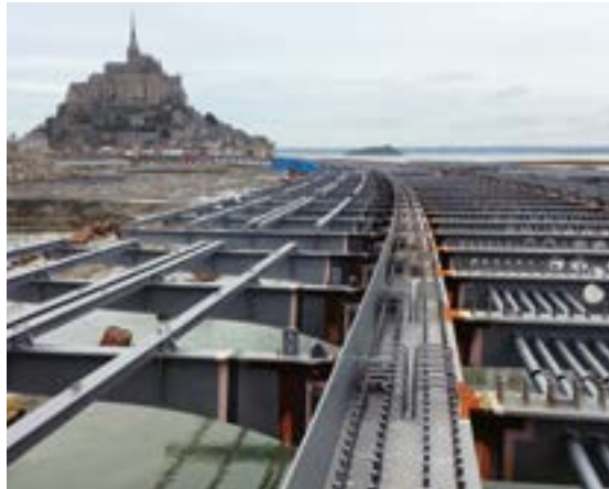
La structure métallique est en place. A gauche, on reconnaît les consoles du cheminement piétonnier ; au centre, les dalles en béton de 25 cm d'épaisseur sont en cours de pose.
