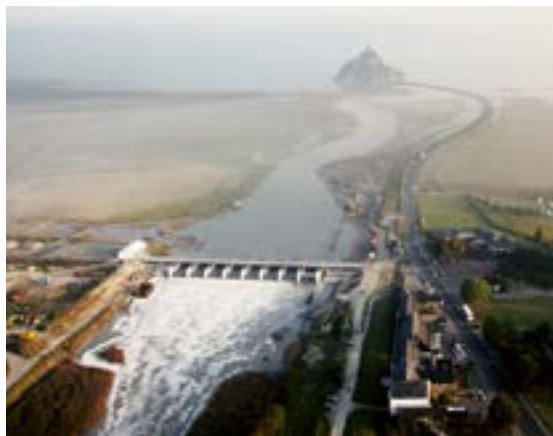
Les eaux sont retenues à marée haute derrière le nouveau barrage sur le Couesnon. A marée basse, l'eau s'écoule à nouveau vers la mer, entraînant avec elle les sédiments accumulés autour du Mont.
