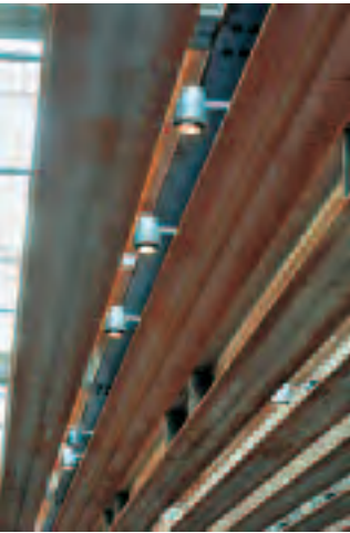
Sichtbare Dachträger aus wetterfestem Baustahl, Museum Sowjetisches Speziallager, Sachsenhausen 2001, Architekten: Schneider + Schumacher
