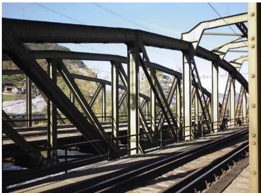
2 – 3 Die Halbparabelträger über die Landquart sind Ständerfachwerke mit fallenden Streben; das ältere, eingleisige Fachwerk von 1911 ist genietet (rechts), beim jüngeren (links), zweigleisigen von 1972 sind Profile und Gurte verschweisst und die Pfosten- und Strebenanschlüsse geschraubt.
