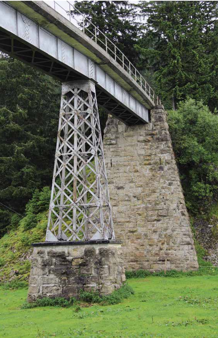
7 Sowohl der Vollwandträger als auch die aufgelösten Fachwerkpfiler sind genietet. Die 1942 aufgesetzte Betonplatte schützt die Eisenkonstruktion vor Witterungseinflüssen.
