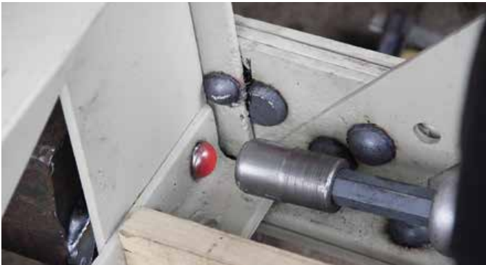
6 Aufwendige Arbeitsschritte von Hand, mit Presslufthammer und mit Schweissbrenner ermöglichen es, die alten Nieten durch neue zu ersetzen.
