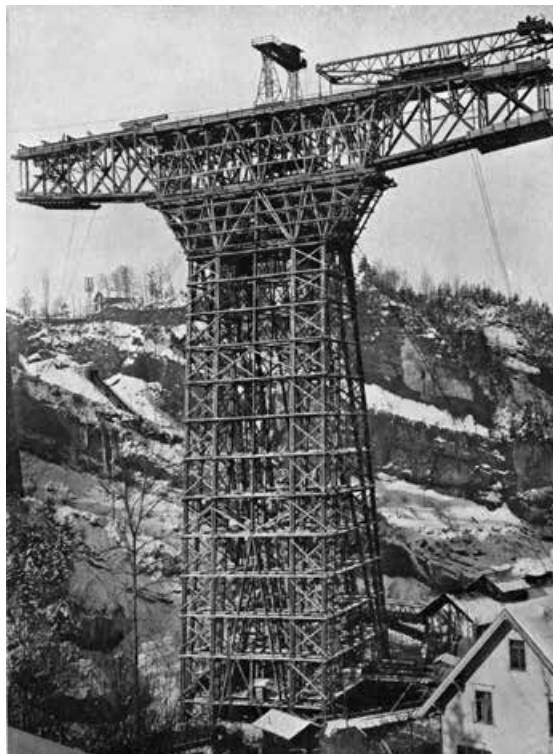
4 Das spektakuläre Lehrgerüst aus Holz für den Bau des Bahnviaduktes über die Sitter, konstruiert von Richard Coray.
