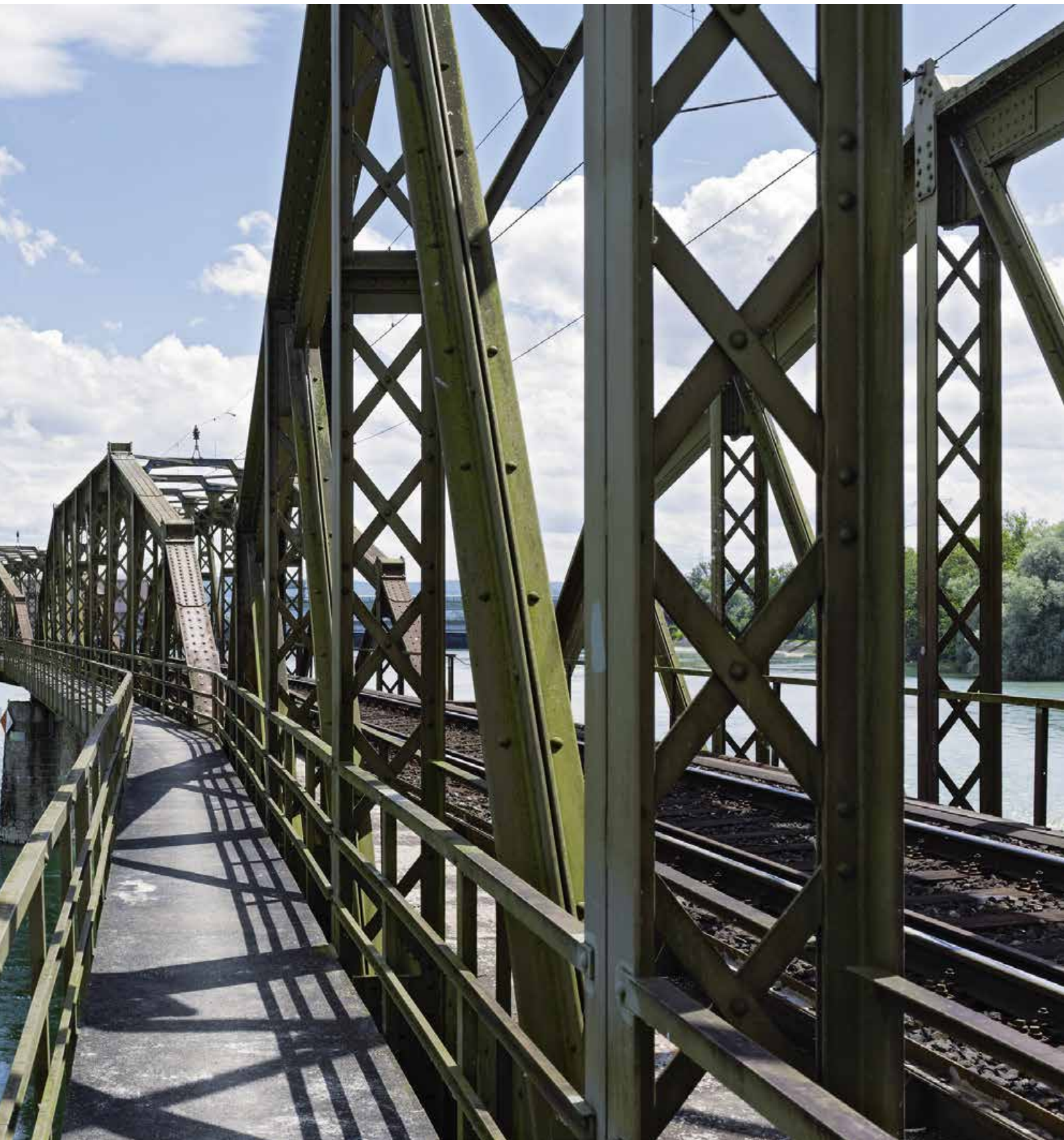
2 Aarebrücke Koblenz von 1892: Fünf Schwedlerträger überbrücken die Aare. Unterwasserseitig ist auf Konsolen aussen an den Hauptträgern ein öffentlicher Fußgängersteg angebracht.
