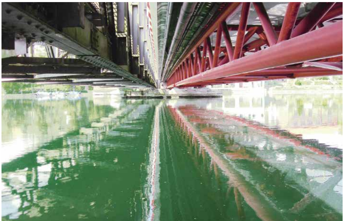
4–5 Jede Stahlkonstruktion überzeugt für sich: Die noch bestehende genietete Stahlbaubrücke für die Eisenbahn von 1907 und die moderne geschweisste räumliche Fachwerkkonstruktion der Strassenbrücke von 1997 (rot).
