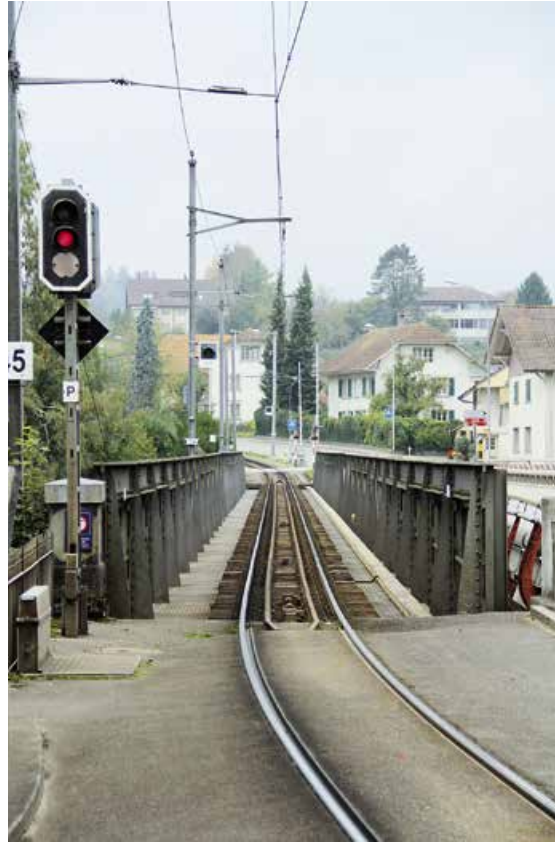
2-3 Die bestehende Stahlbrücke über die Aare bei Aarwangen der Aare Seeland mobil; die Fachwerkkonstruktion soll ersetzt werden.
