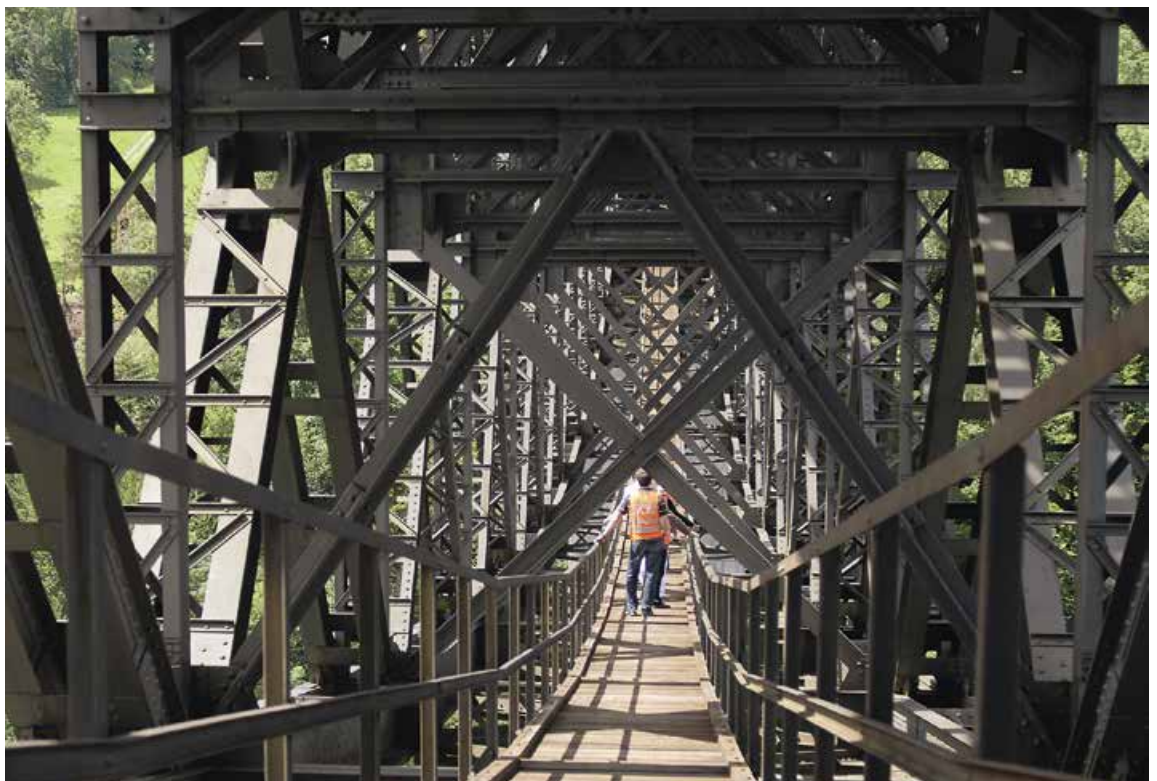
1 Wartungsgang des Bahnviaduktes über die Sitter bei St. Gallen von 1919
