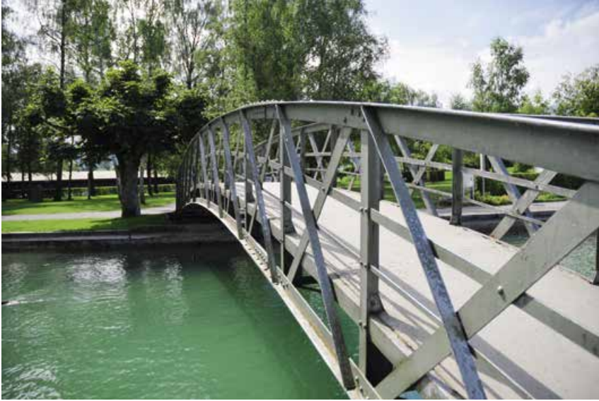
2 Die geschützte Fussgängerbrücke Birkenwäldli am Strandweg in Unterägeri vor der Restauration.
