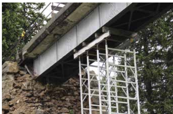
8 Der Vollwandträger ist Innen mit Querträgern aus Diagonalkreuzen ausgesteift.
