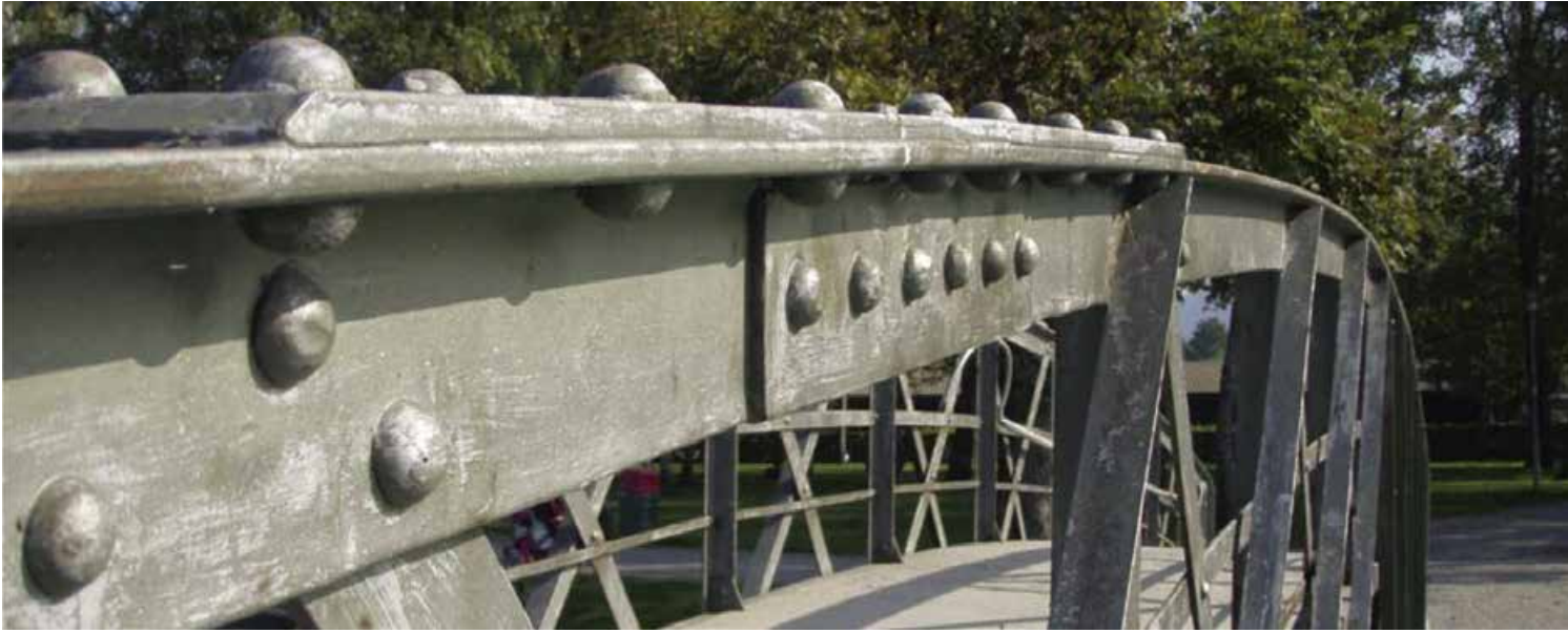
7 Genietet Stahlverbindung am Bogenbrüggli vor der Restauration. Der Schutzzumfang betrifft den Standort der Baute, seine äussere, historische Erscheinung und die ursprüngliche Konstruktion.
