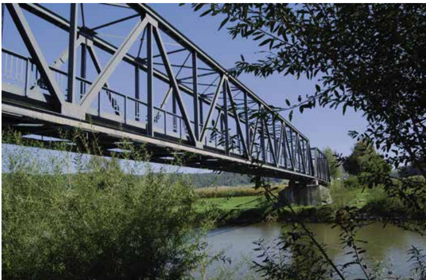
Die Thurbrücke bei Gütighausen ist eine Strassenbrücke, die nur einspurig befahrbar ist. Sie wurde 1988 verlängert.
