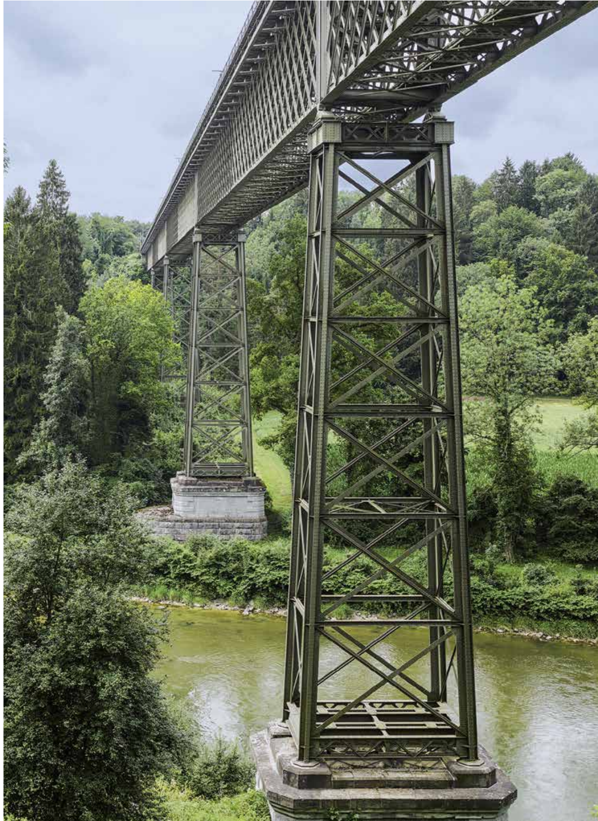
Die Thurbrücke Ossingen von 1875 ist die letzte Schweizer Bahnbrücke mit eisernen Pfeilern, die noch in Betrieb ist. Sie ist zudem mit einer Gesamtlänge von 332 m und einer Höhe von 42 m die grösste historische Stahlbrücke der Schweiz. (Foto: Georg Aerni)
