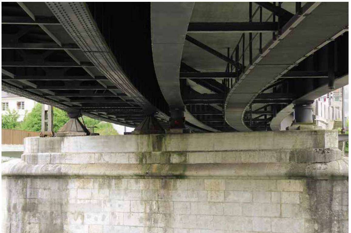
1 Die Aarebrücke der Gäubahn in Olten mit gekrümmten Vollwandträgern; links genietet, rechts verschweisst.
