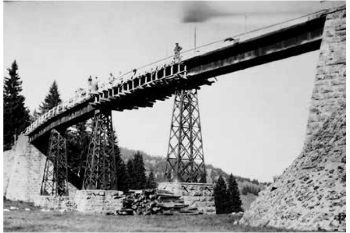
4 Brückenuntersicht mit Holzschalung von 1942: Die filigrane Brücke erhält eine Fahrbahnplatte aus Beton, damit sie nach Stilllegung der Bahn von Fahrzeugen und Wandernern genutzt werden kann.
