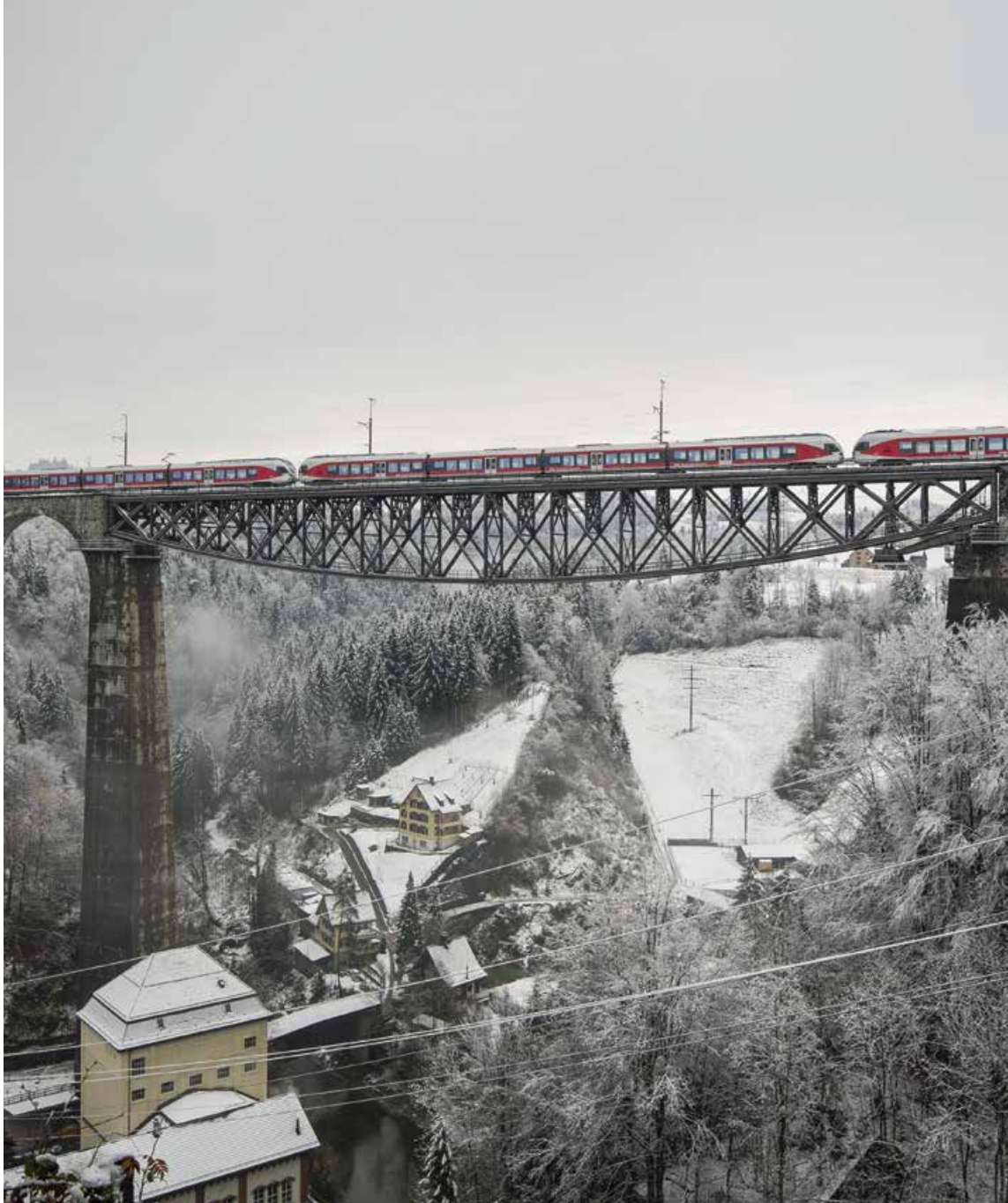
3 Der Bahnviadukt über die Sitter bei St. Gallen von der Südostbahn (SOB) – ehemals Bodensee-Toggenburg-Bahn – wurde 1910 fertig gestellt. Die Brücke ist mit 99 m Höhe die höchste und der Stahlfachwerkträger mit 120 m der weitest gespannte der Schweiz.
