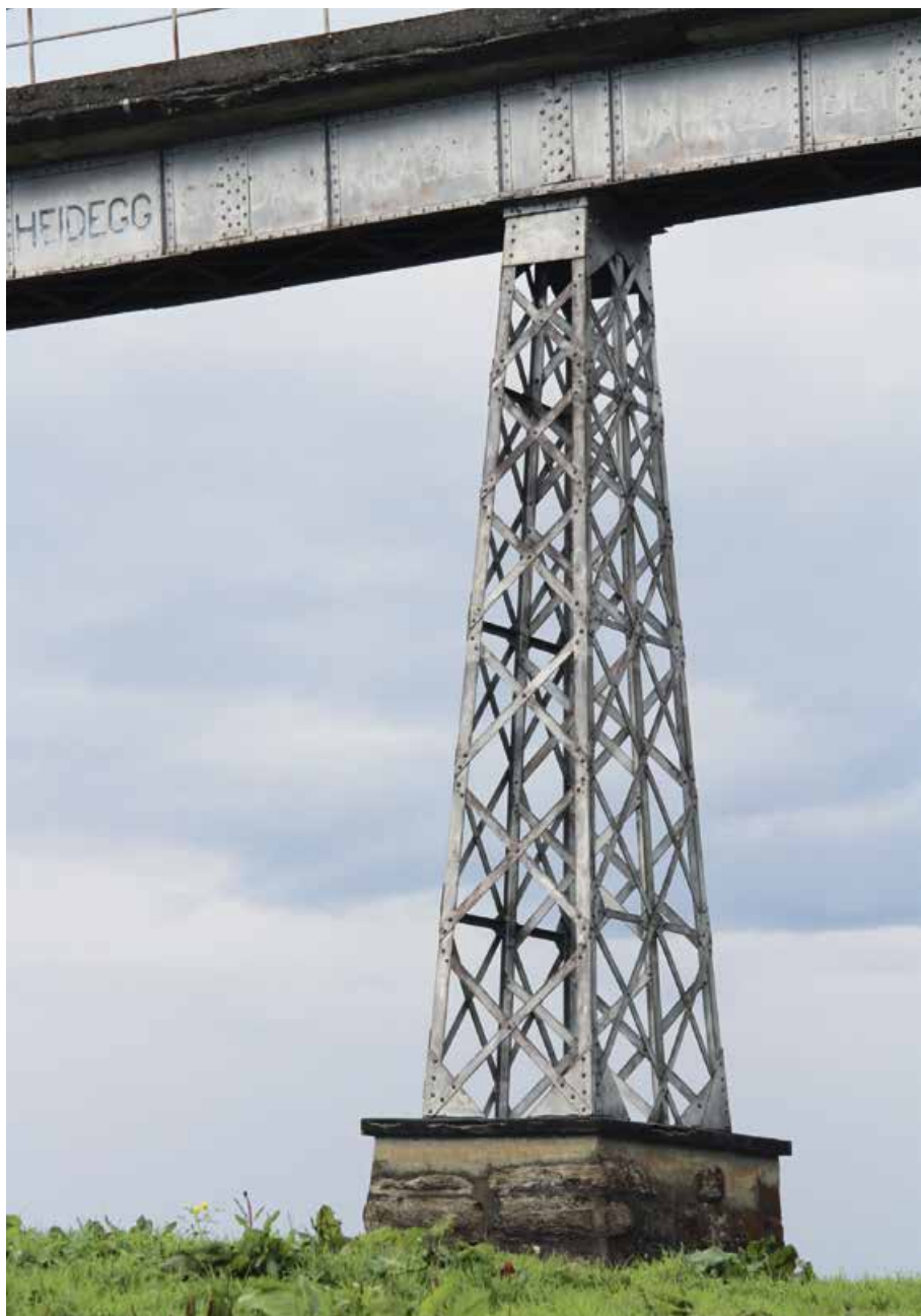
2 Vollwandig, genietet und polygonal ist der Träger und filigran, konisch und aufgelöst sind die Pfeiler konstruiert. (Planausschnitt: Archiv Rigi Bahnen)
