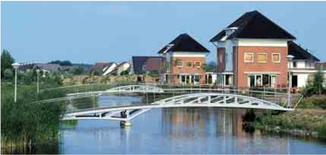
Zwei Brücken mit asymmetrischem Tragwerk verbinden Park und Wohngebiet.
