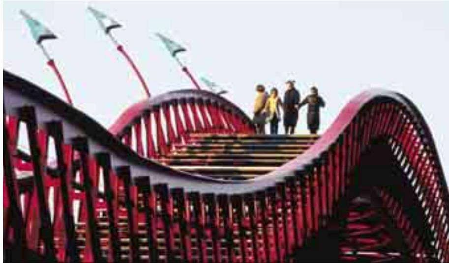
Die Fachwerkträger bilden zugleich das Geländer seitlich des getrepten Brückendecks.
