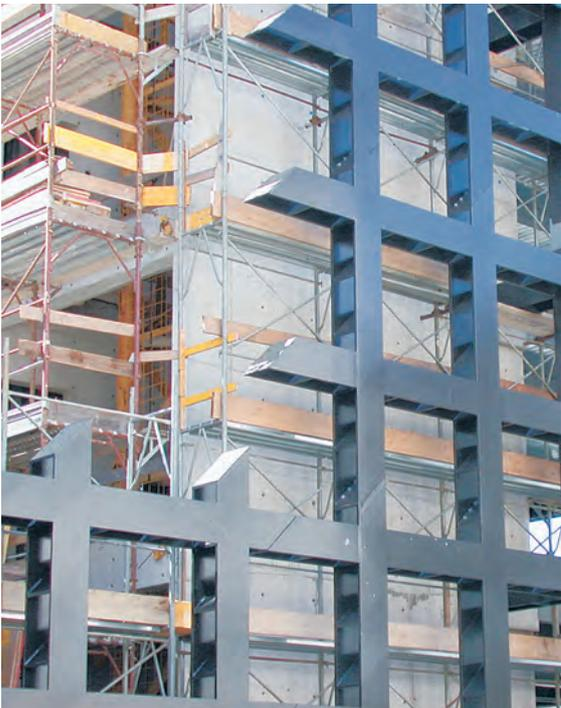
Die vier Fassaden setzen sich aus insgesamt 144 im Werk vorgefertigten Elementen von durchschnittlich 4,5 Tonnen Gewicht zusammen.
