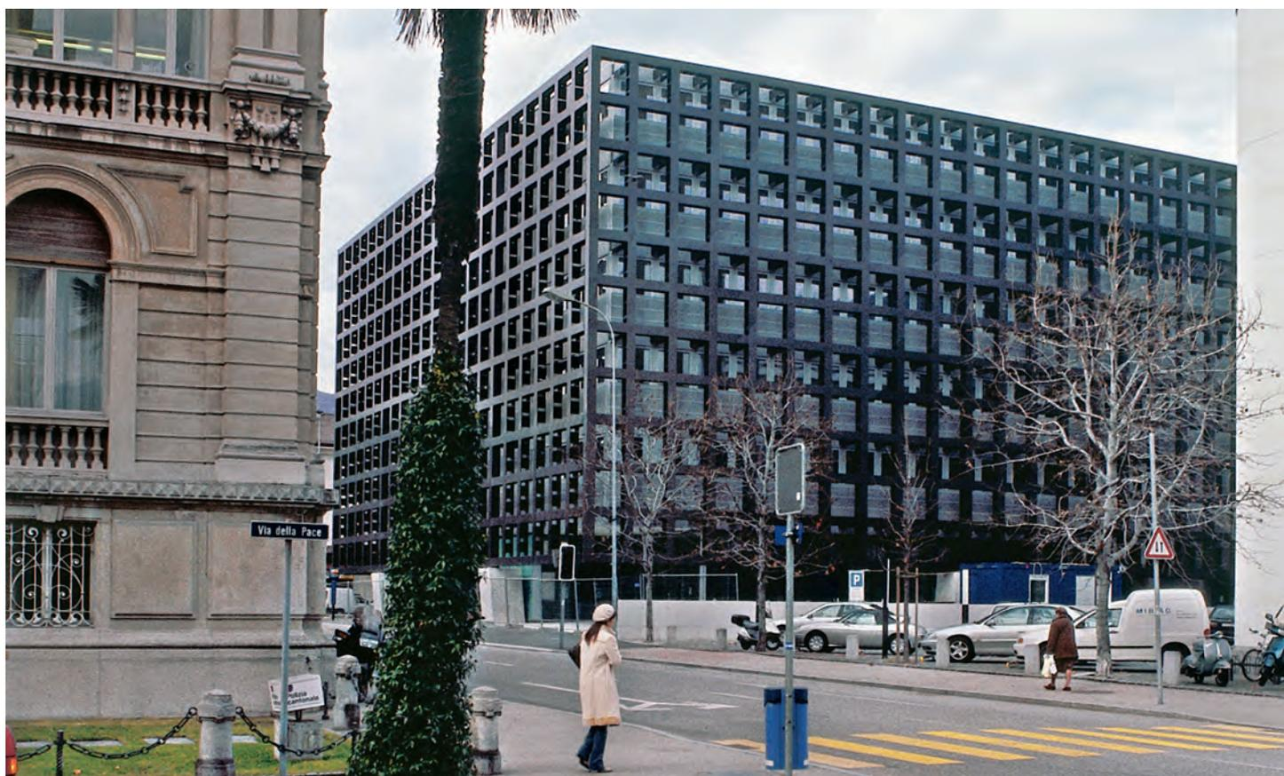
Radikales Manifest eines Entwurfsgedankens, umgesetzt mit Hilfe der Ingenieure. Das aussenliegende Stahltragwerk lässt das Haus zu einem durchlässigen, räumlichen Gebilde werden.
