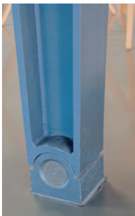
Fusspunkt des Zweigelenrahmens; die Stahlhauptträger sind auf dünnen Pendelstützen aufgelagert; Rahmenecke und heruntergehängte Decke im Eingangsbereich
