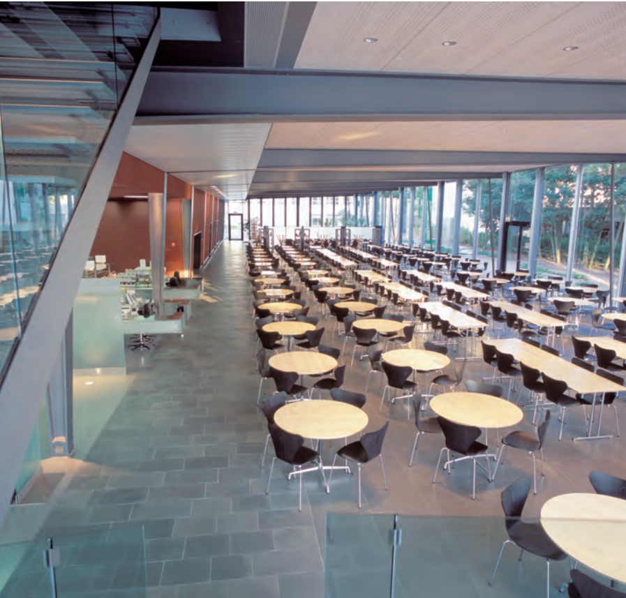
Sorgfältige Fügung der Elemente: Stahlquerträger, Längsträger, vorgefertigte Holzdecken mit integrierter Beleuchtung und abgehängte Decke.
