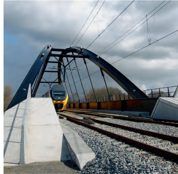
Die Führung der Oberleitung ist in den Entwurf der Brücke integriert.
