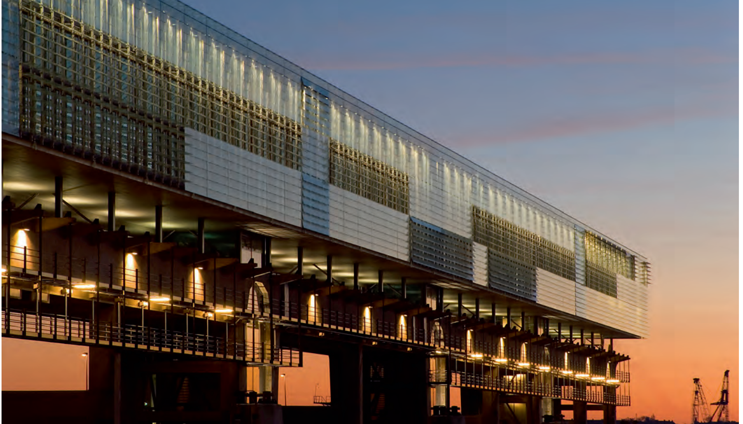
Die doppelte Glasfassade ermöglicht einen einzigartigen Ausblick auf die umliegende Hafenlandschaft.
