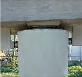
Abb. 5: Mit einer Schwächung wird die Steifigkeit und damit die anfängliche Neigung der Kapazitätskurve reduziert. Es resultieren kleinere Kräfte aber grössere Verschiebungen. Beispiel: seitliche Nocken zur schwimmenden Längslagerung auf einem Pfeiler einer Autobahnbrücke in Basel.
