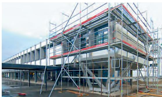
Abb. 6: Vom Ingenieur ursprünglich entworfenes Stahlfachwerk (oben rechts) und in Zusammenarbeit mit dem Architekten entwickeltes räumliches Stahlfachwerk (unten rechts) zur Verstärkung der Fassadenwände des Collège de l'Europe in Monthey
