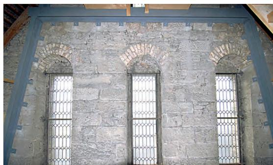
Abb. 8: Erdbebensicherung der beiden Giebelwände der Ruhmeshalle aus Mauerwerk mittels Stahlfachwerk.
