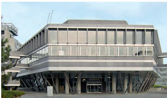
Abb. 1: Typische Schwachstellen bezüglich Erdbebenverhalten: Gebäude mit unsymmetrischer Aussteifung (Hörsaalgebäude der ETH Zürich)
